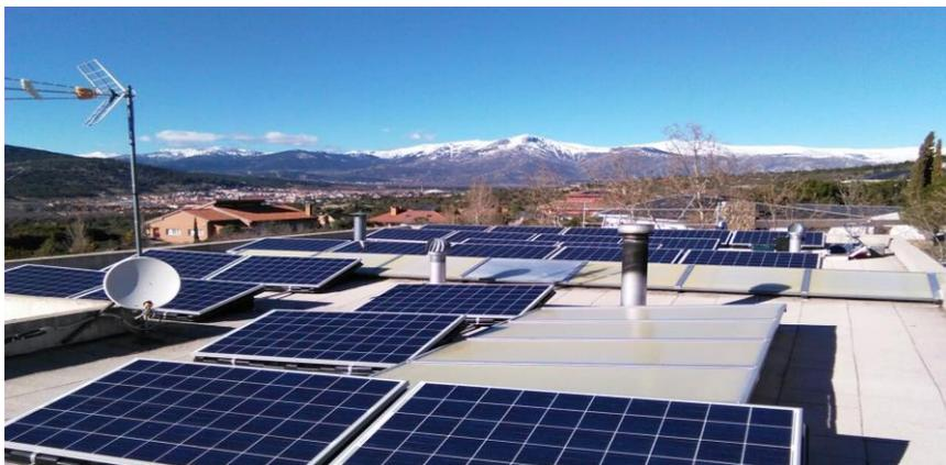
Figura 1-1. Instalación solar fotovoltaica con placas solares en la cubierta de una vivienda unifamiliar.
