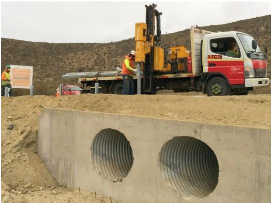
Figura 5-1. Instalación de tubos corrugados.
