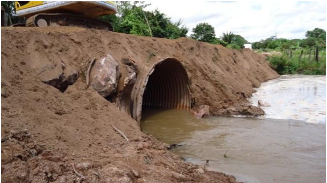
Figura 3-5.Tubo corrugado provisional en una obra.
