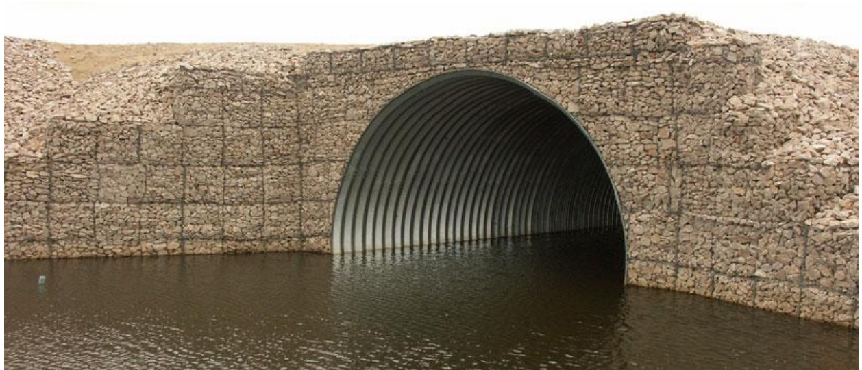
Figura 3-9. Tubo corrugado con calado estable durante un gran período de tiempo.
