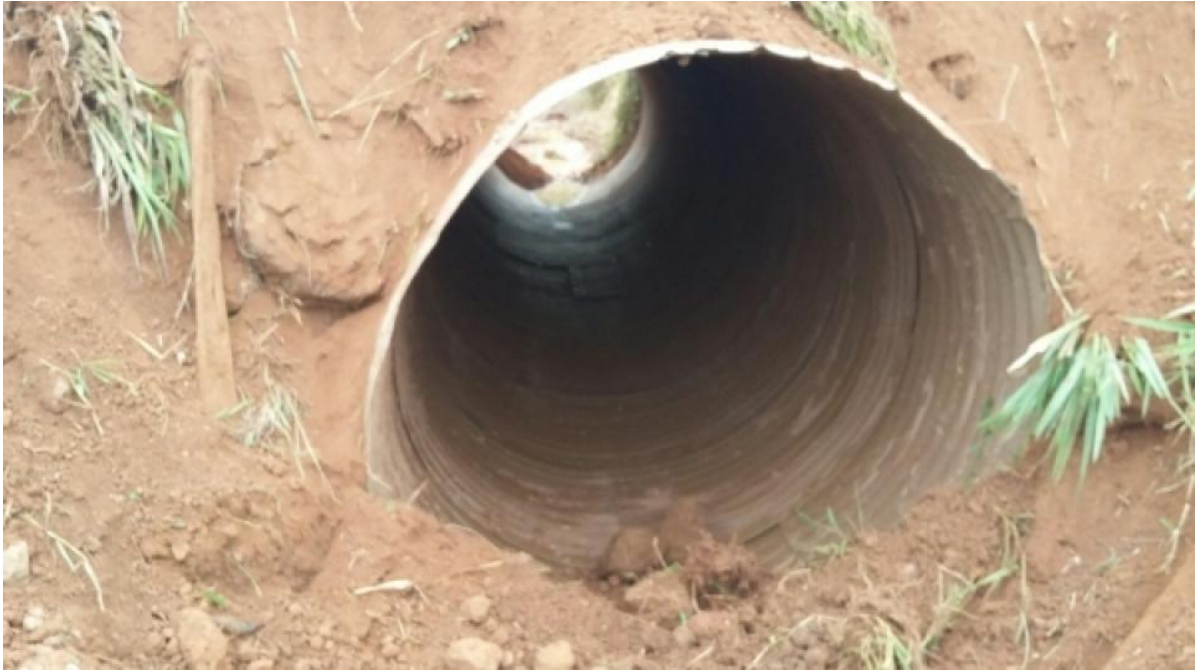
3-8. Interior del tubo corrugado.
