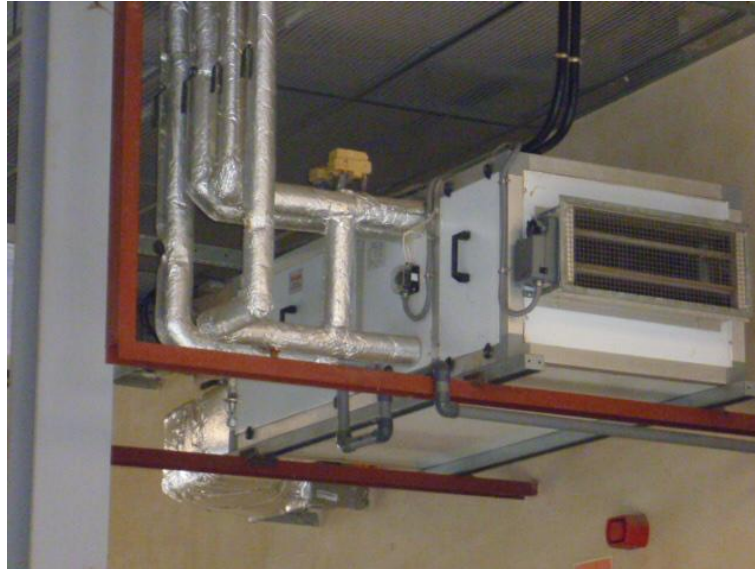
Figura 23 Unidad de tratamiento de aire a 4 tubos
