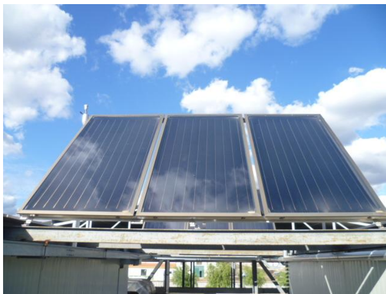
Figura 17 Colectores solares planos producción de A.C.S.
