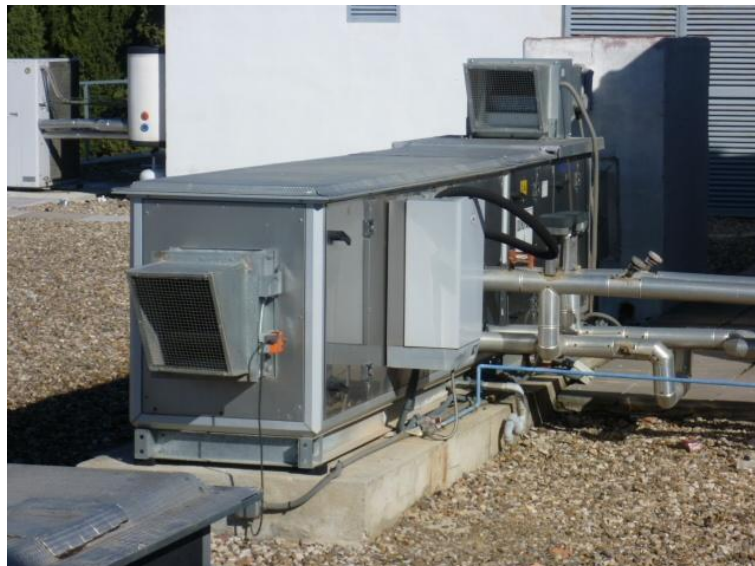
Figura 24 Unidad de tratamiento de aire a 4 tubos
