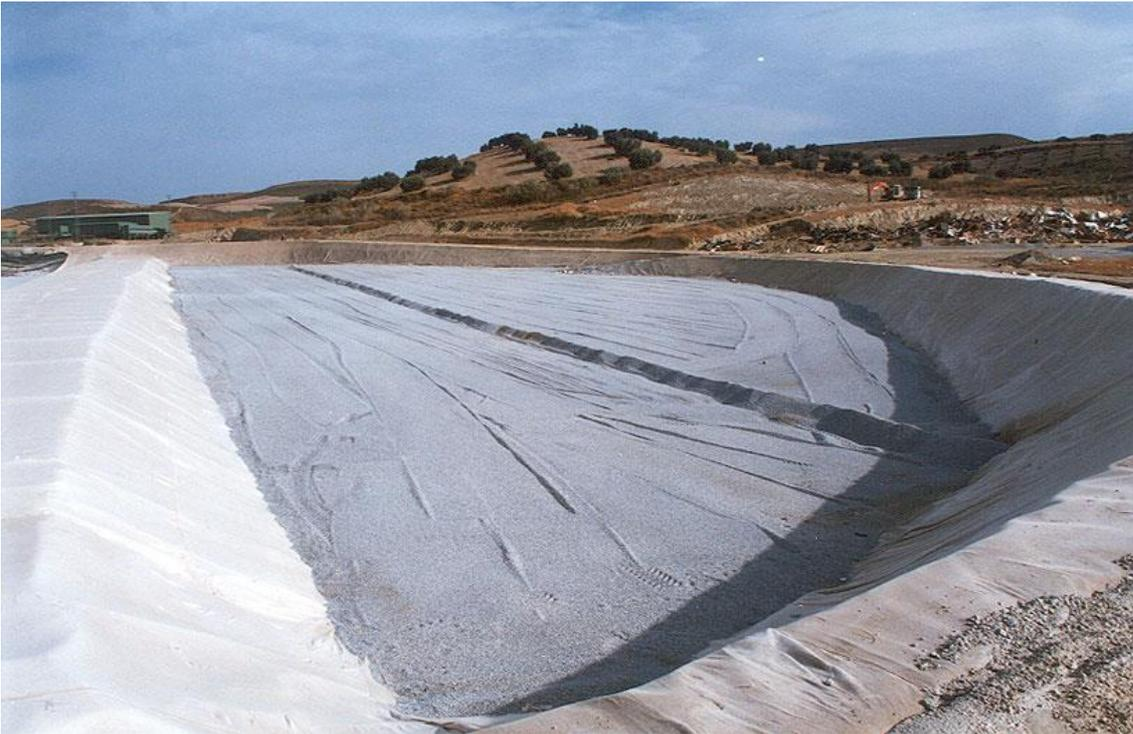
Figura 2-3: Vaso vacío de vertedero con recubrimiento [8]
