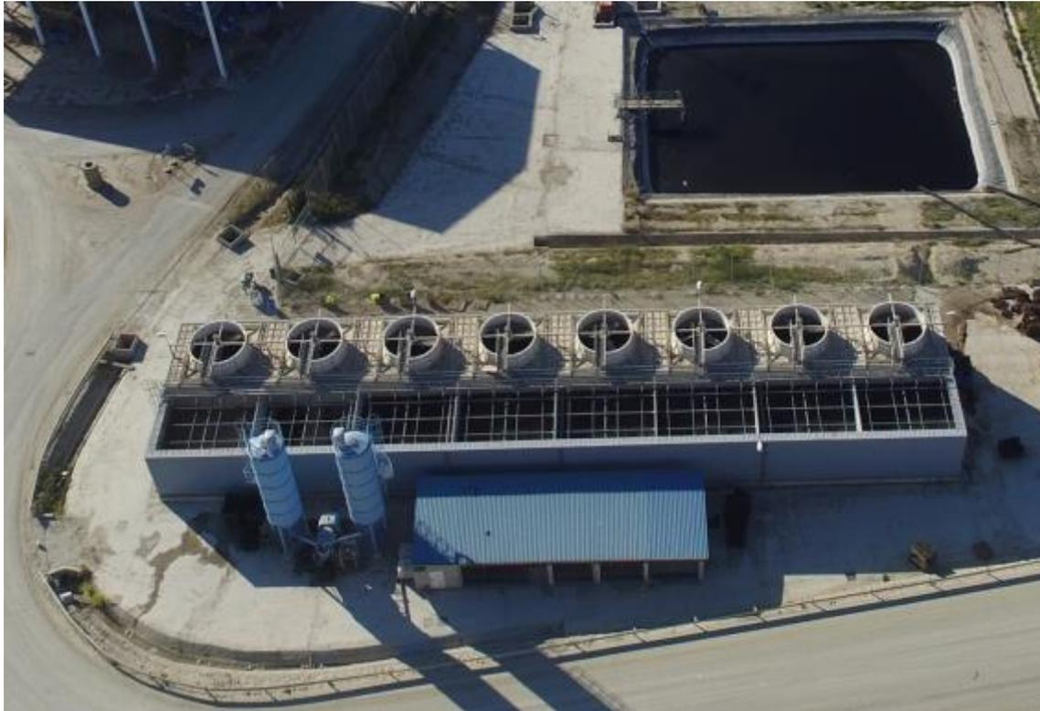
Figura 3-1: Detalle de la planta de eliminación de lixiviados. Fuente: Ecocentral Granada
