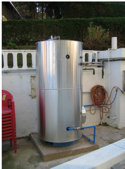
Figura 1.22 Acumulador de ACS de 1500 litros para instalación solar en un hotel en Cantabria.(Fuente: “Icarus Solar. Energías renovables.”)
