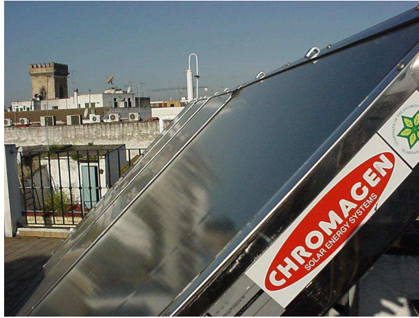
Figura 1.18 Captador con carcasa de aluminio anodizado
