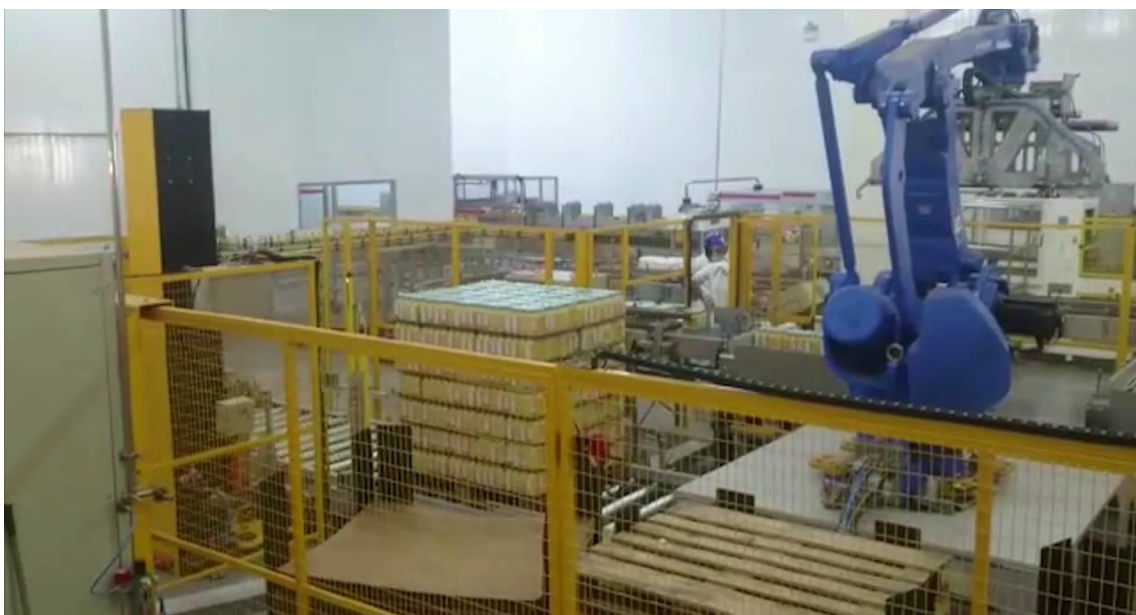
Figura 1.8 Zona de paletizado
