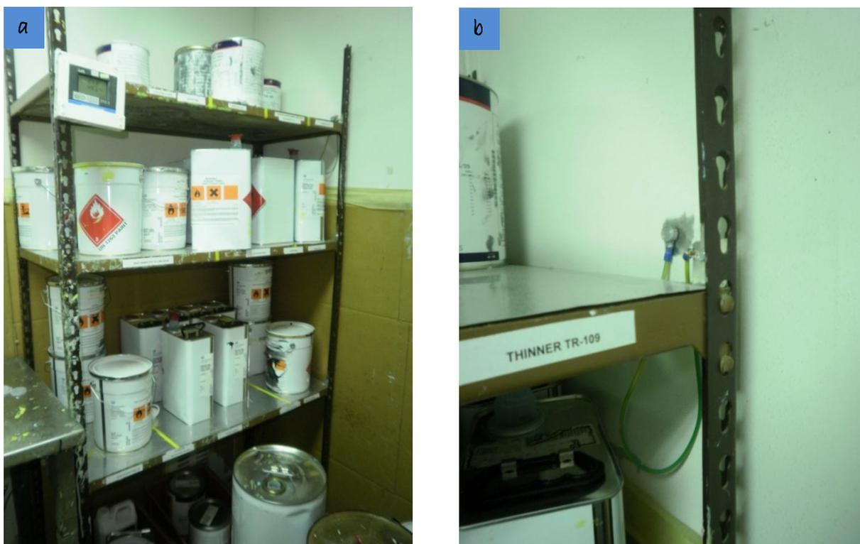
Figura 23. a) Estantería del box de pintura. b) Toma de tierra de la estantería.
