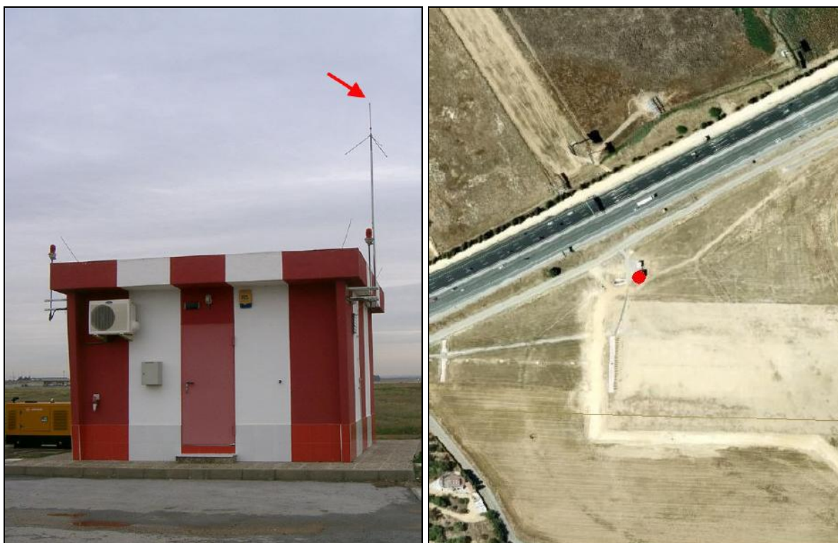
Imagen y situación de la caseta de equipos del localizador 09
