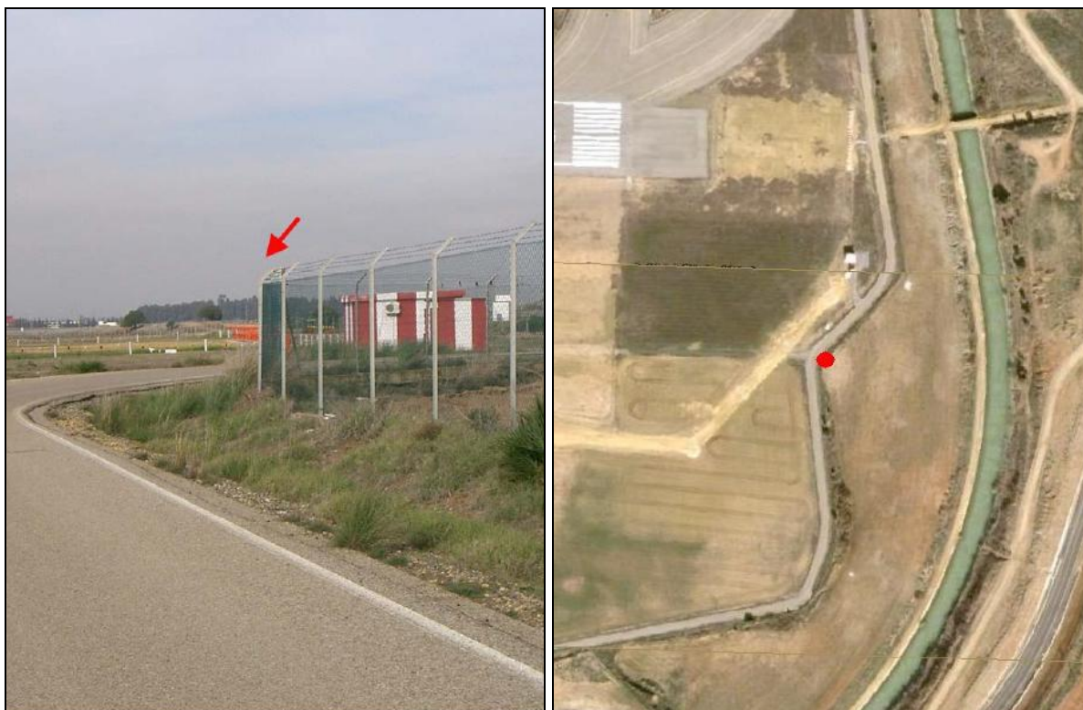
Imagen y situación del vallado perimetral en cabecera 27 en el Aeropuerto de Sevilla
