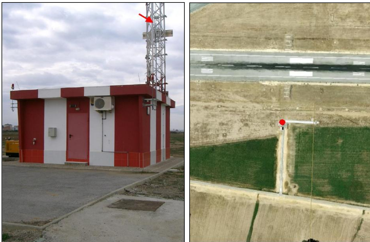
Imagen y situación de la antena de la senda de planeo 09
