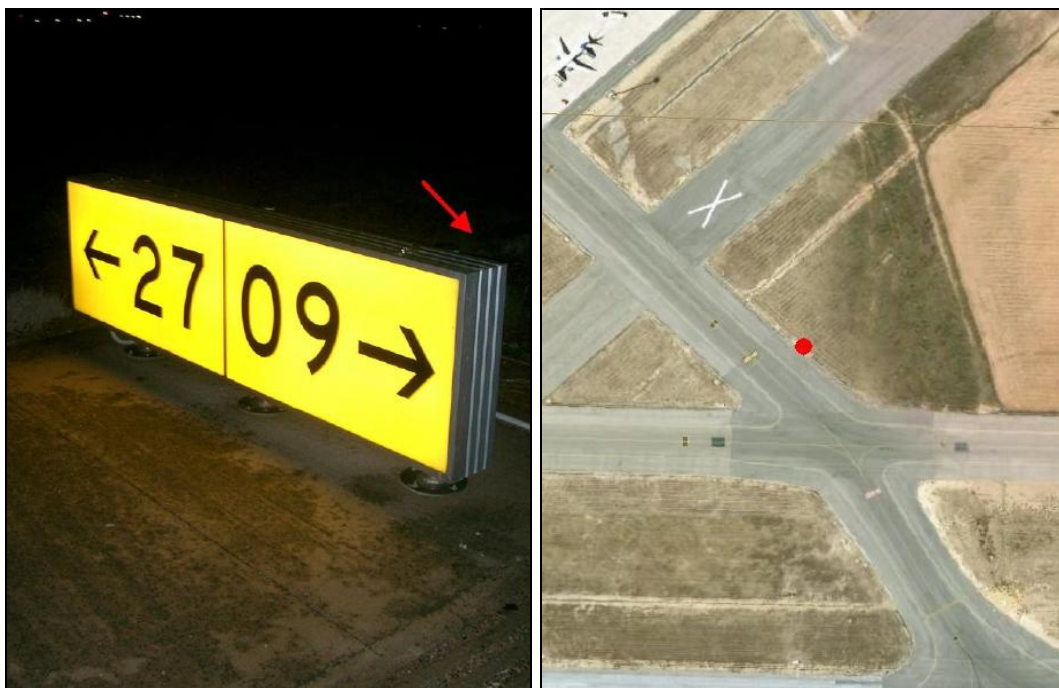
Imagen y situación de un letrero con indicaciones de dirección en el Aeropuerto de Sevilla
