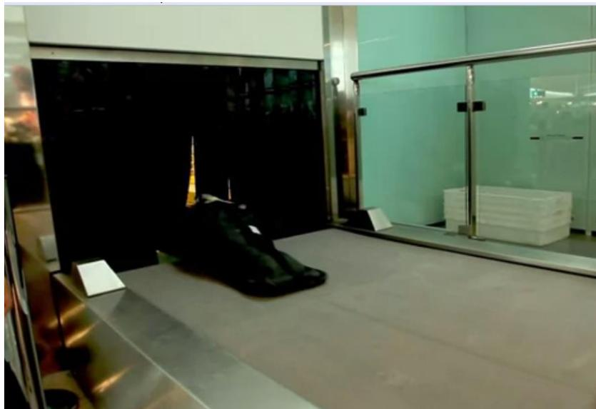
A diferencia de los equipajes normales, los especiales no emplearán cintas transportadoras inclinadas en su descenso desde la planta 1 a la planta 0, si no que se habilitará un ascensor que realizará esta función. Existe un lector RFID previo a la llegada al elevador que se encarga de activar automáticamente su funcionamiento.
