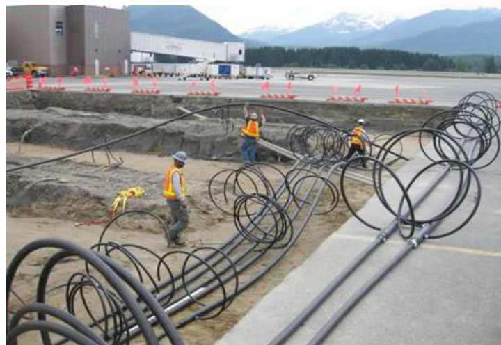
Imagen 7.- Construcción de la instalación horizontal de captación geotérmica en el Aeropuerto de Juneau (Alaska, EEUU) 14 .
