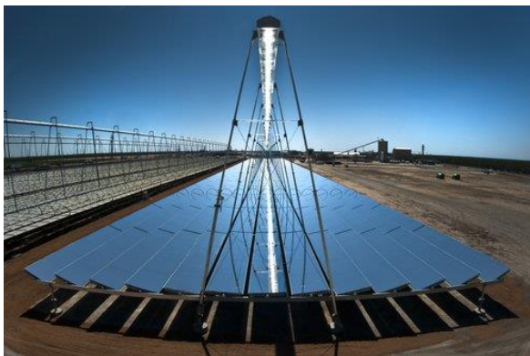
Imagen 27.- Reflectores Fresnel 47 .
