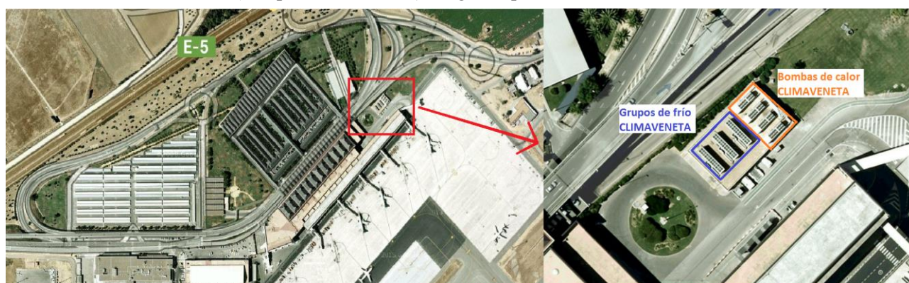
Imagen 43.- Situación de la Central Energética y los equipos de climatización CLIMAVENETA.
