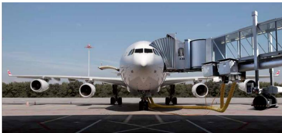
Imagen 37.- Sistema central para electricidad y aire acondicionado 55 .
