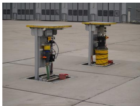
Imagen 39.- Conexiones autoelevables de agua y aire acondicionado para un sistema subterráneo 56 .
