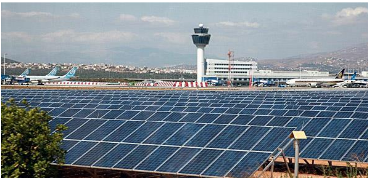
Imagen 26.- Instalación fotovoltaica en el Aeropuerto de Atenas (Grecia) 46 .
