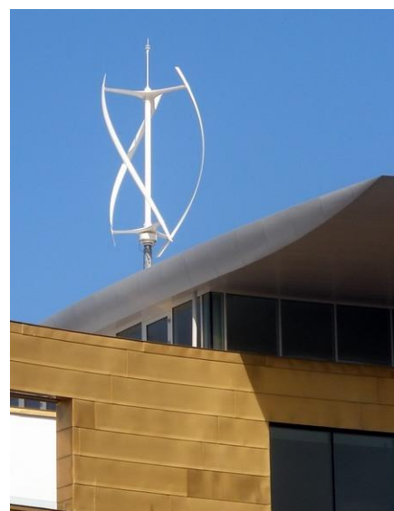
Imagen 36.- Micro-turbina eólica de eje vertical sobre tejado 53 .
