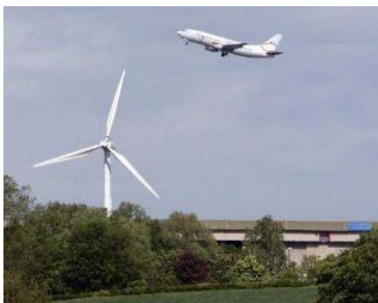
Imagen 34.- Aerogenerador convencional en el Aeropuerto East Midlands (Inglaterra) 51 .
