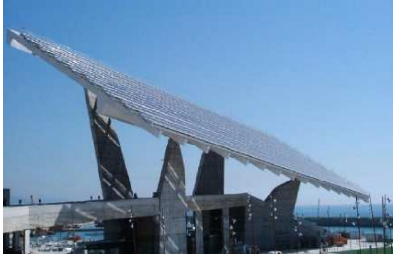
Figura. Conexión a red. Central fotovoltaica.
