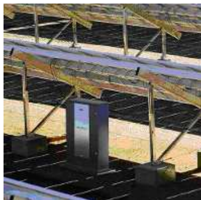
Figura. Inversor central en planta fotovoltaica.
