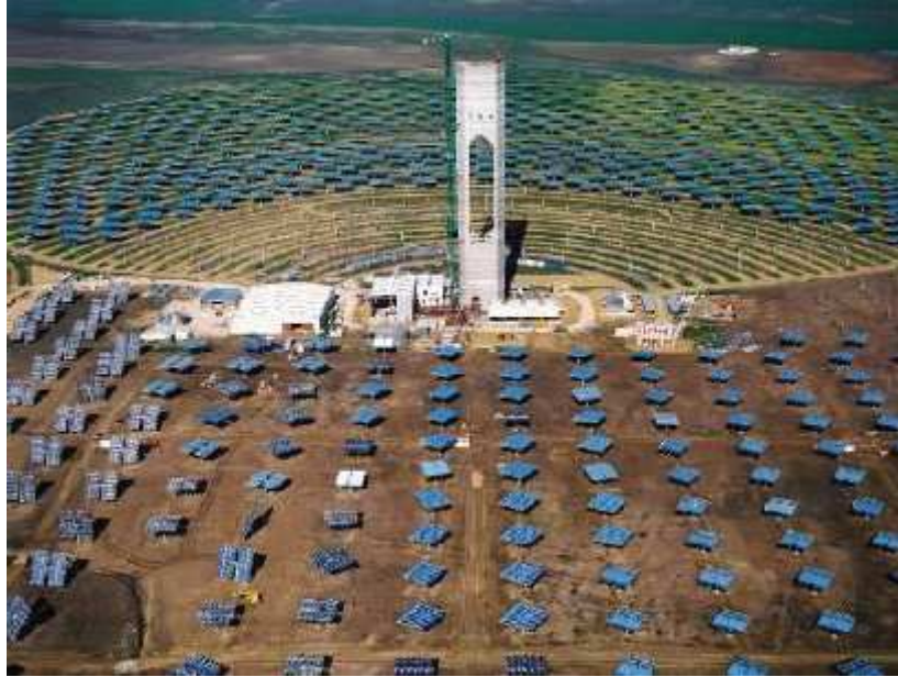
Figura. Central solar termoeléctrica de torre PS10 de Abengoa (en construcción).
