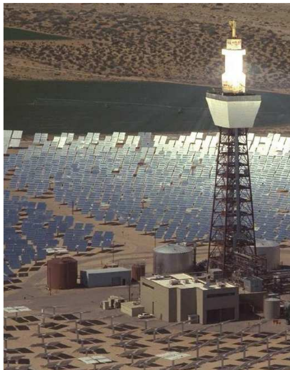
Figura. Central solar termoeléctrica de torre.
