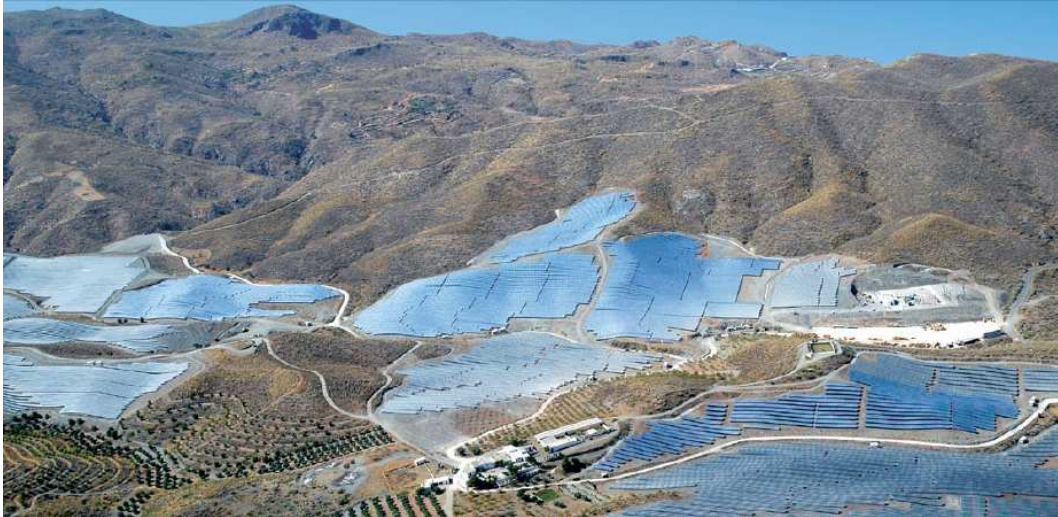
Figura. Planta solar fotovoltaica. Lucainena de las Torres, Andalucía, España.
