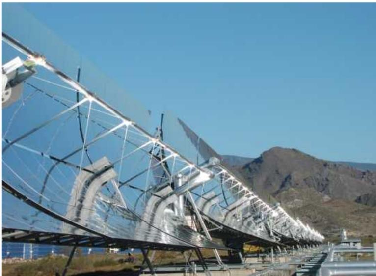
*Imagen 10: reflectores cilindro-parabólicos*
