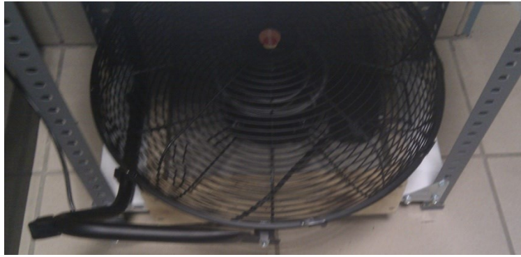
Ilustración 60. Base de la estructura
