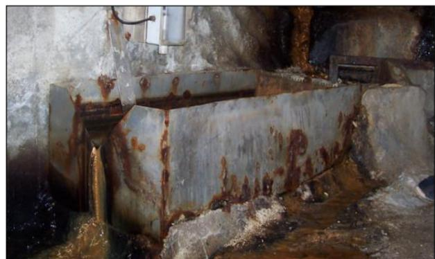
Para obtener datos fiables sobre los caudales filtrados, dentro de las actuaciones objeto del presente proyecto, se realizará la sustitución de los 5 aforadores dañados, así como la instalación de reglillas para la lectura manual de las filtraciones.
