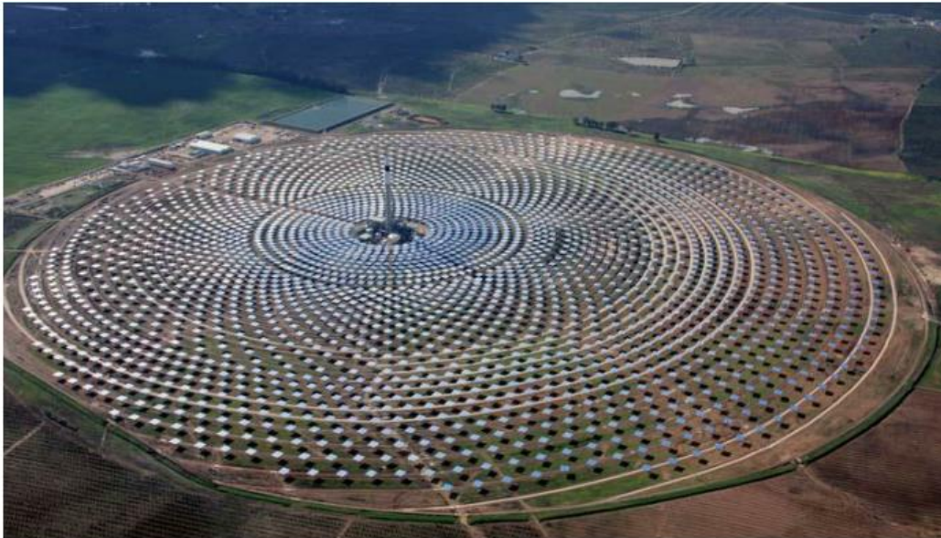
Figura 7. Planta Gemasolar de receptor central en Sevilla
