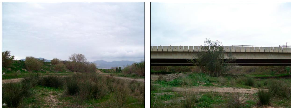
Figura 2-9 Sección cauce aguas abajo – Punto n°4
