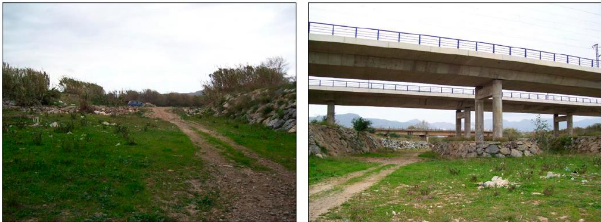
Figura 2-13 Sección cauce aguas arriba – Punto n°5
