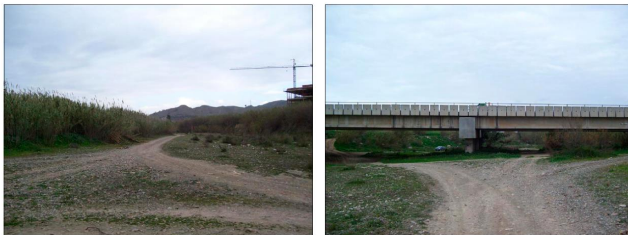
Figura 2-10 Sección cauce aguas arriba – Punto n°4
