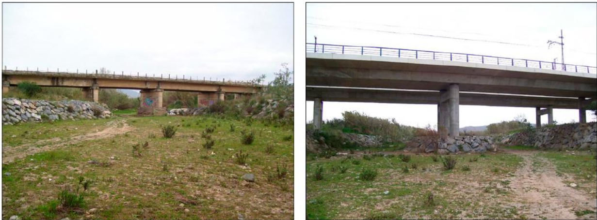
Figura 2-12 Sección cauce aguas abajo – Punto n°5
