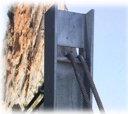
Figura 5.6. Detalle de unión entre cables y vigas de los extremos de la pasarela. Fuente: Elaboración propia.
