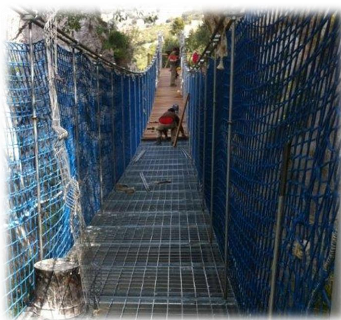
Figura 5.3. Colocación de trámex y madera en el tablero de la pasarela. Fuente: Metalhergos S.L.
