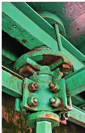
Figura 23. Detalle de capitel de pilote con el nudo de enlace y apoyo de las vigas principales
