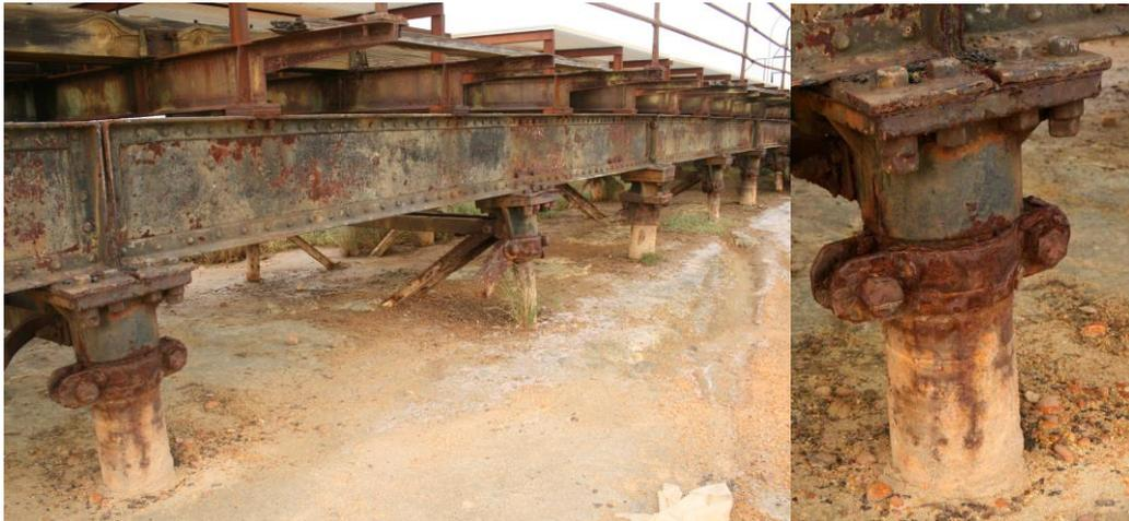
Figura 14. Pilotes en la actualidad, donde se observa la corrosión y la colmatación.
