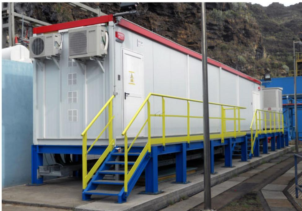
Figura 4-23. Planta del proyecto Store de almacenamiento con ultra condensadores situada en la central eléctrica de Los Guinchos (La Palma)
