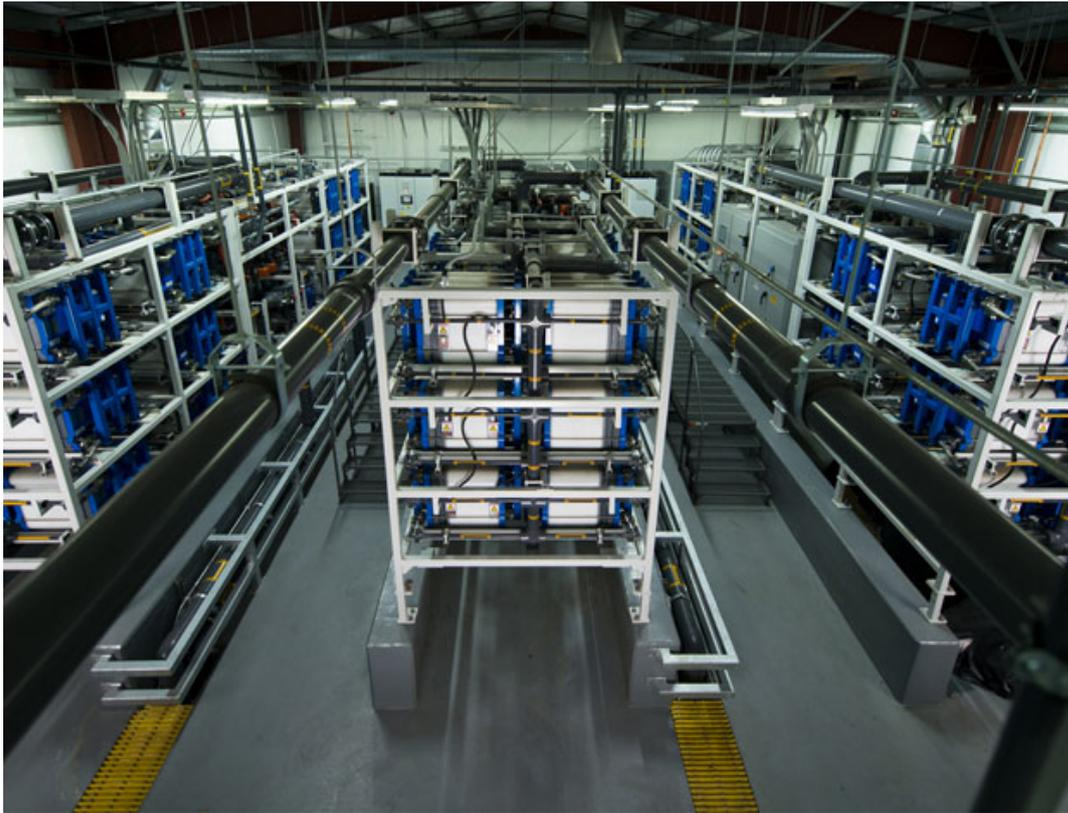
Figura 4-22. Baterías de flujo de redox
