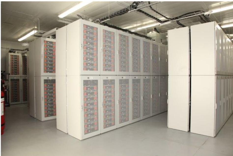
Figura 4-14. Baterías Ion-Litio para almacenar energía en el parque eólico Tehachapi
