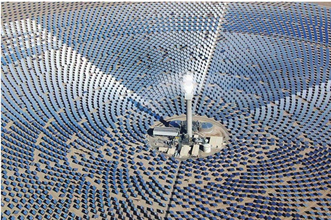
Figura 4-26. Almacenamiento térmico mediante sales fundidas en termosolar de torre
