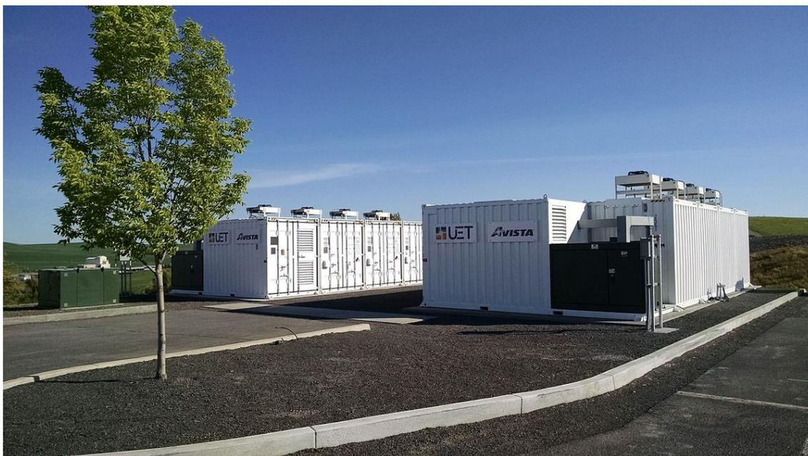
Figura 4-21. Batería Redox 1MW en pullman (Washington)
