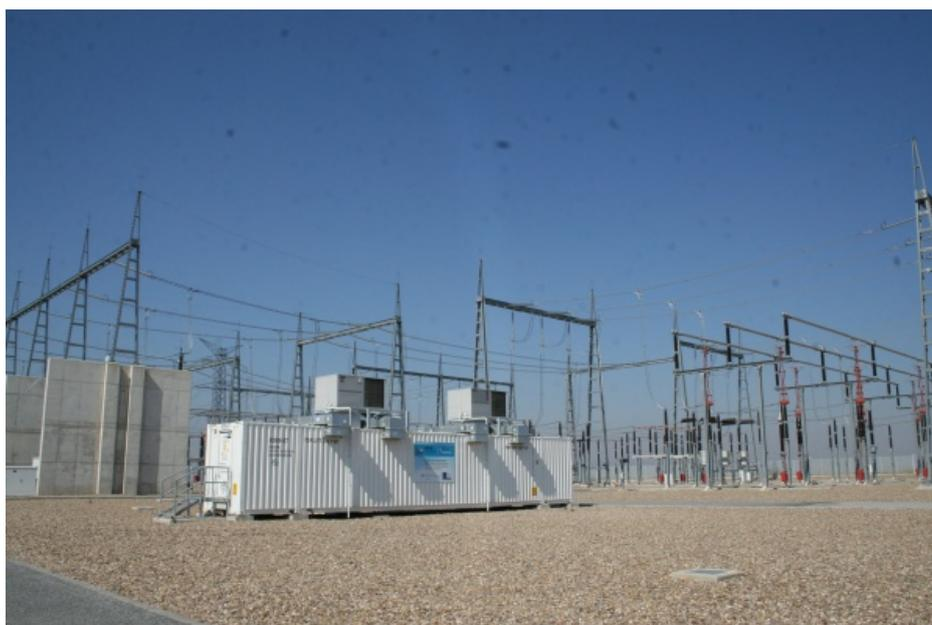
Figura 4-15. Batería de ión-litio instalada en la subestación de transporte de Carmona (Sevilla)
