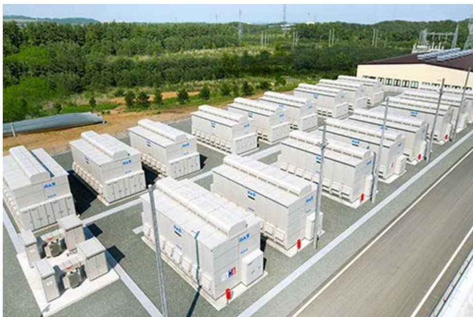
Figura 4-19. Baterías de NaS instaladas en el parque eólico de Rokkasho, en Aomori (Japón)
