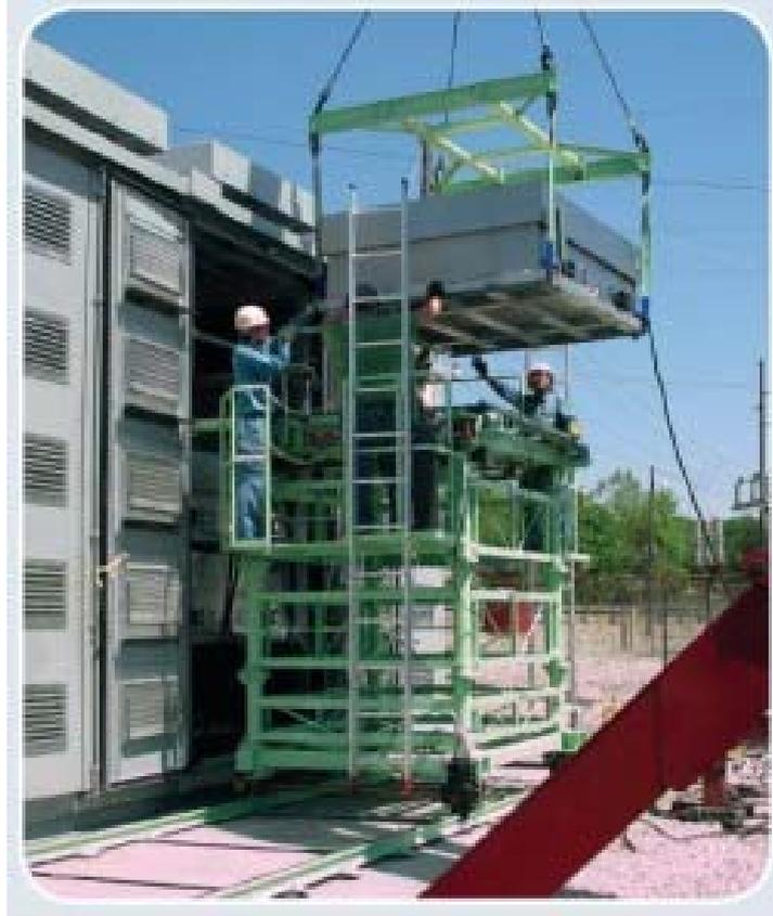
Figura 4-18. Módulo de Batería NaS en Luverne (Minnesota)
