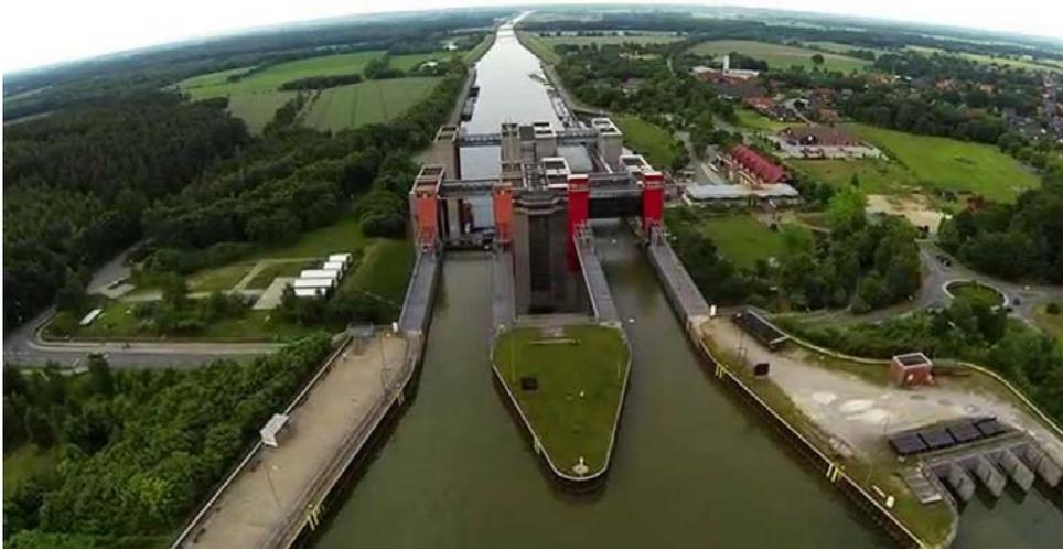
Figura 4-4. Ascensor de barcos de Scharnebeck, Lüneberg, utilizado para almacenar energía con capacidad de 25 MWh
