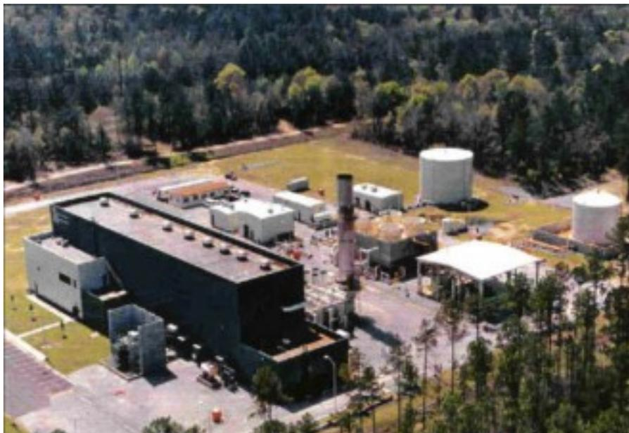
Figura 4-11. Planta de almacenamiento de aire comprimido en McIntosh – Alabama (Estados Unidos)
