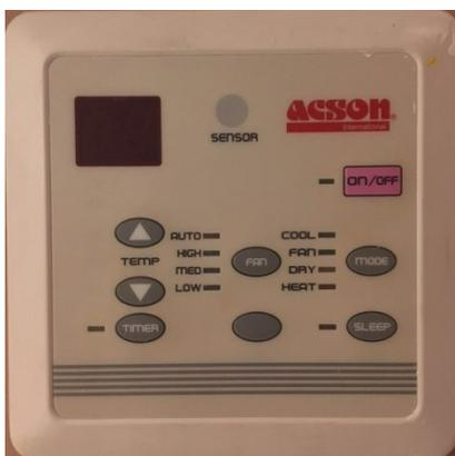
Figura 5-38. Mandos del sistema de climatización.
