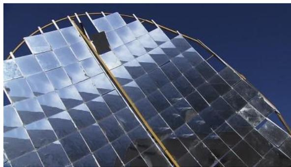
Figura 11. Matriz de espejos de un disco parabólico
