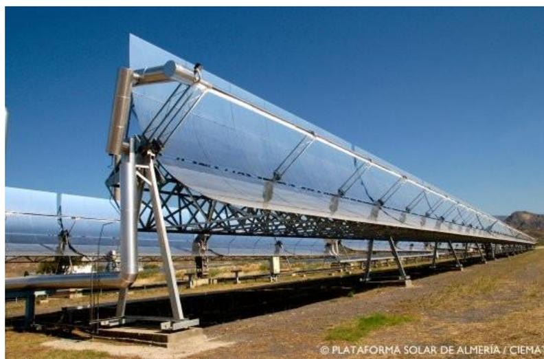
Figura 3. Central cilindro parabólico
