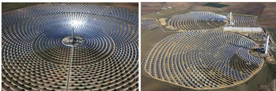
Figura 7. Distribución del campo de heliostatos de la central Gemasolar (izquierda) y PS20 (derecha)
