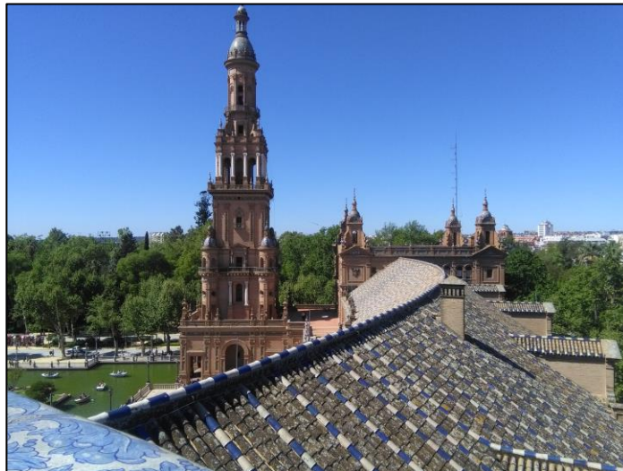
Figura 10. Cubierta a dos aguas con acabado en teja
