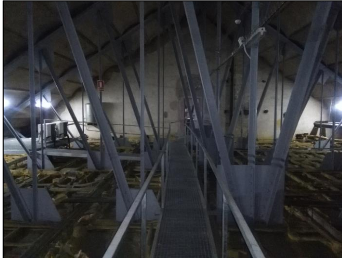
Figura 9. Estructura de cerchas metálicas bajo tablero y tejas
