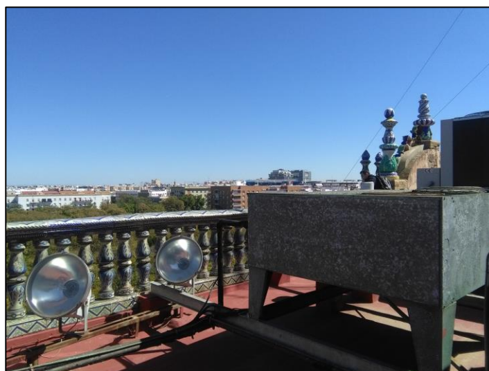
Figura 11. Zona de cubierta transitable en CHG
