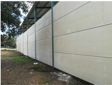
Figura 31. Ejemplo nave con panel embebido
