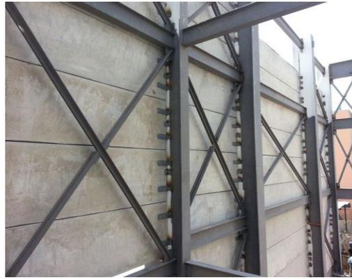
Figura 16. Ejemplo union panel con pilar mediante conectores metálicos
