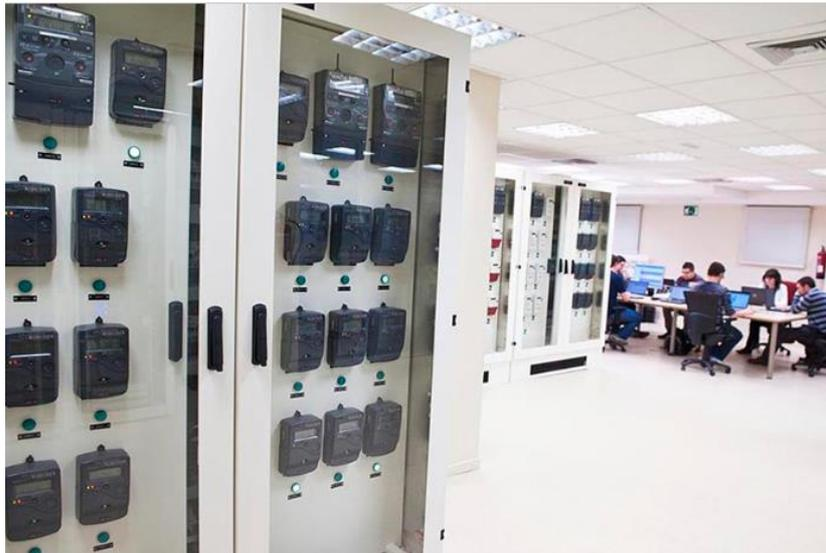
Ilustración 62 Armario de contadores inteligentes de la microrred del LINTER [39]
