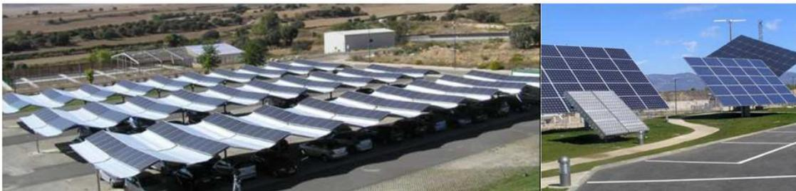
Ilustración 68 A la izquierda, instalación de placa fija instalada en las marquesinas del parking. A la derecha, Seguidores solares en el parking de FHA.[42]
