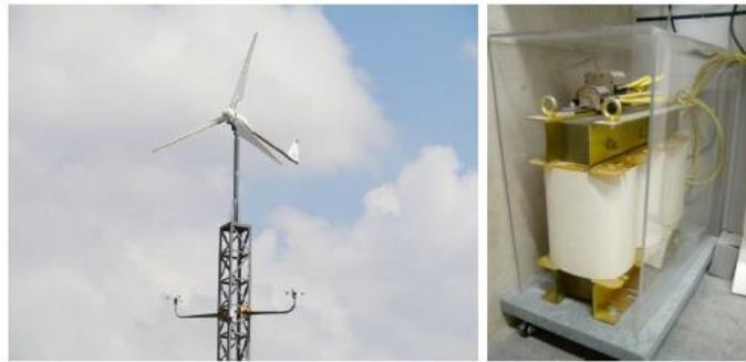
Ilustración 44 Aerogenerador Bornay sobre la torre de 20 m y transformador.(UPNA). [29]
