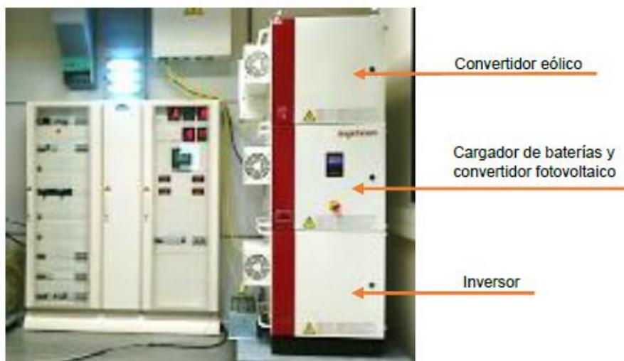
Ilustración 42 Convertidor Ingecon Hybrid MS30, con sus tres módulos, de arriba abajo: (1) convertidor eólico, (2) cargador de baterías y convertidor fotovoltaico y (3) inversor. (UPNA) [29]
