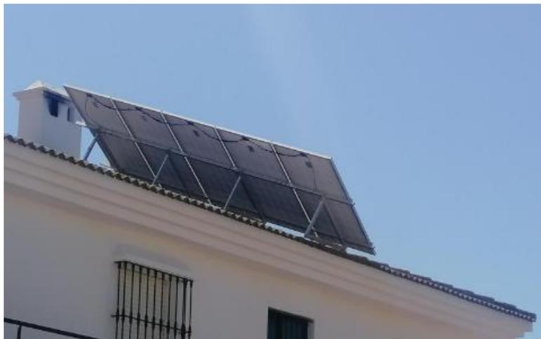
Figura 4.6 Instalación elevada hacia orientación sur. Elaboración propia.
