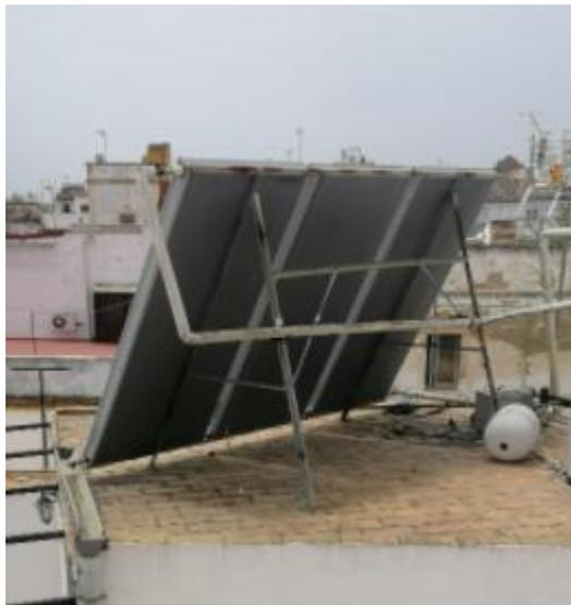
Figura 4.7 Instalación sobre cubierta plana. Elaboración propia.
