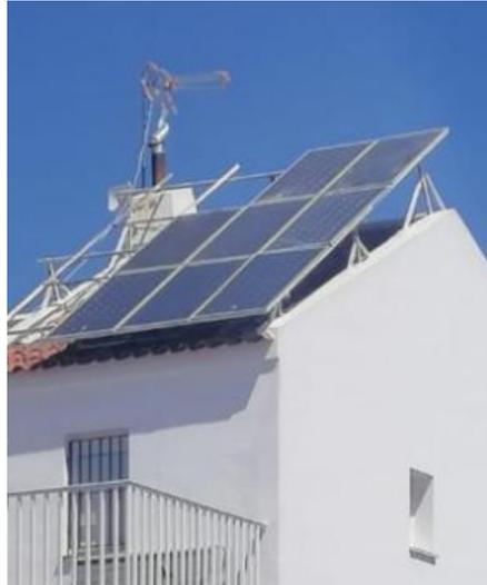
Figura 4.5 Instalación coplanar sobre cubierta orientada al sur. Elaboración propia
