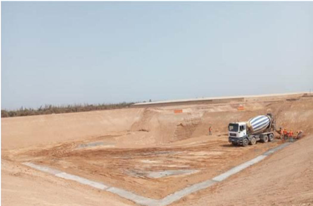
Figura 16: Trabajos de excavación.
