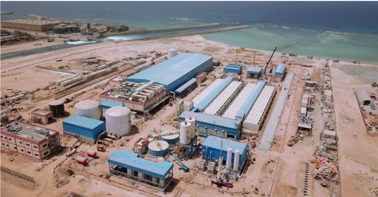
Figura 13: Edificios de la planta de desalación.
