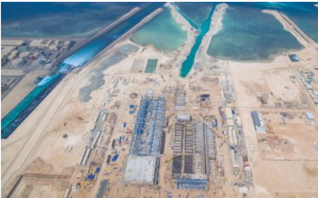
Figura 21: Finalización de la construcción.
