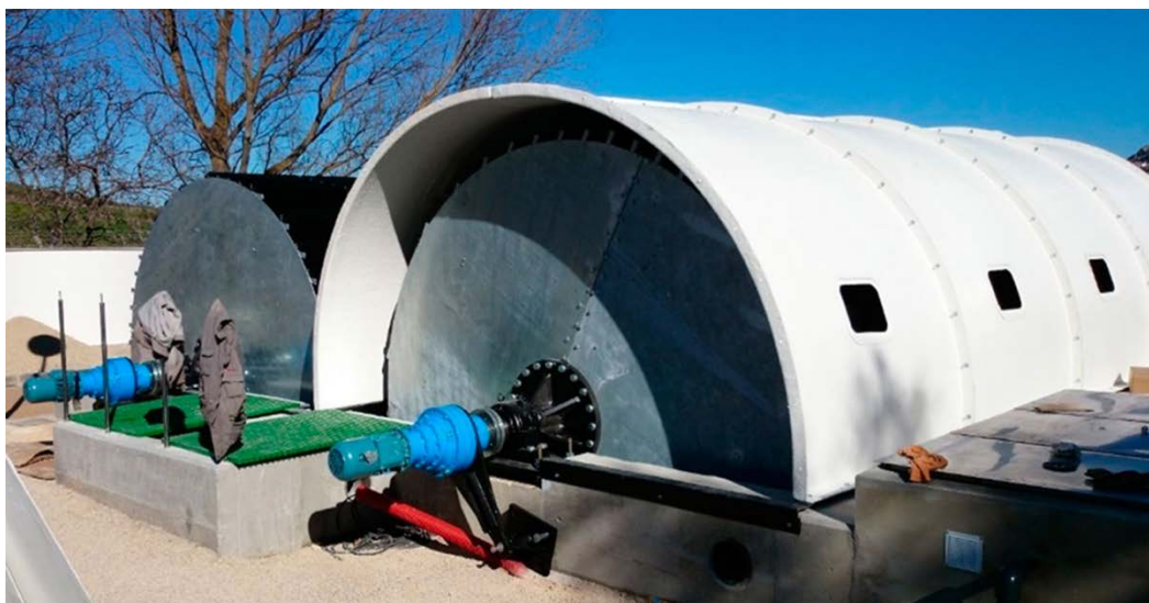
Figura 5-13. Instalación Avanzada de un Biodisco de Dos Etapas en Campo. Fuente: https://hidrometalica.com/biodiscos/ .
