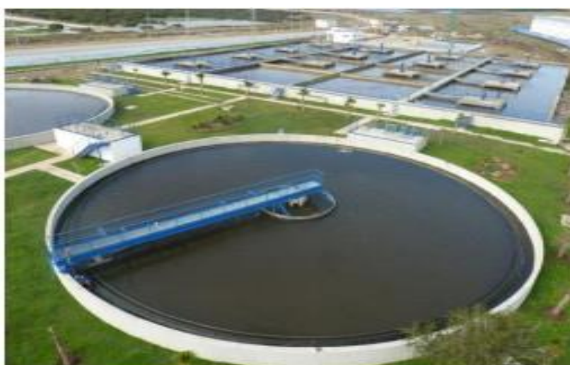
Foto 2: vista general de la EDAR de Tánger
