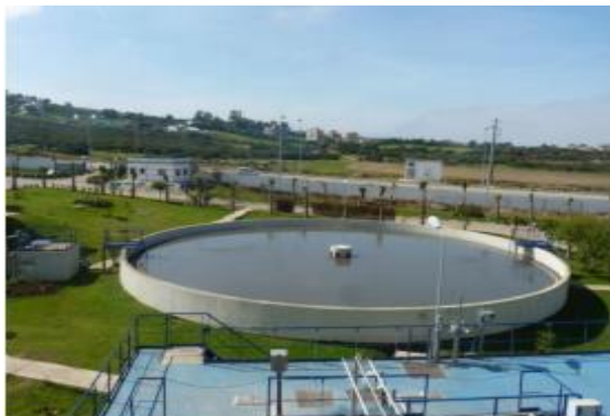
Foto 15: tanque de homogeneización desagüe
