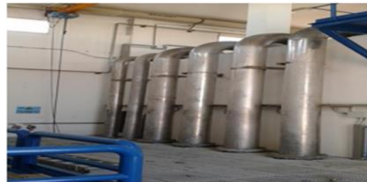
Foto 6: pozo de bombeo de elevación
