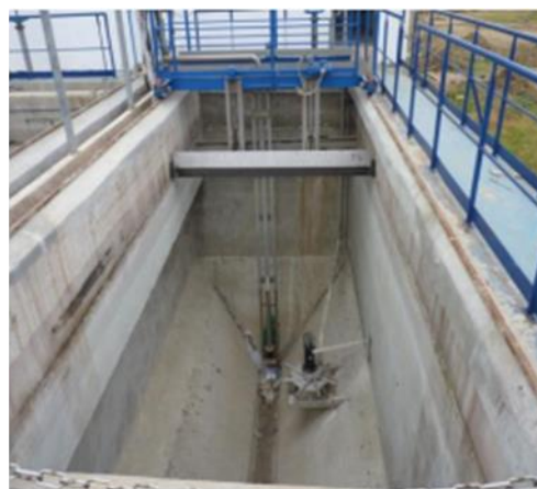
foto 11: puente raspador
