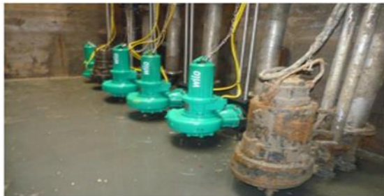
Foto 5: bombas sumergidas
