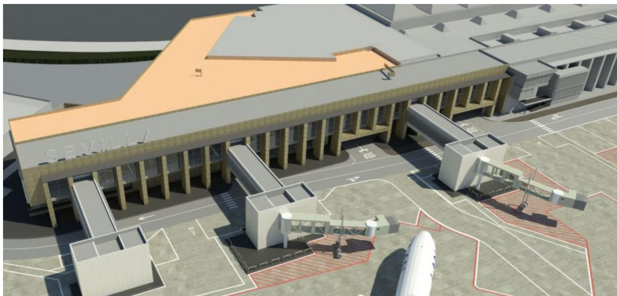
Figura 2-3. Obra de remodelación de la terminal del aeropuerto de Sevilla
