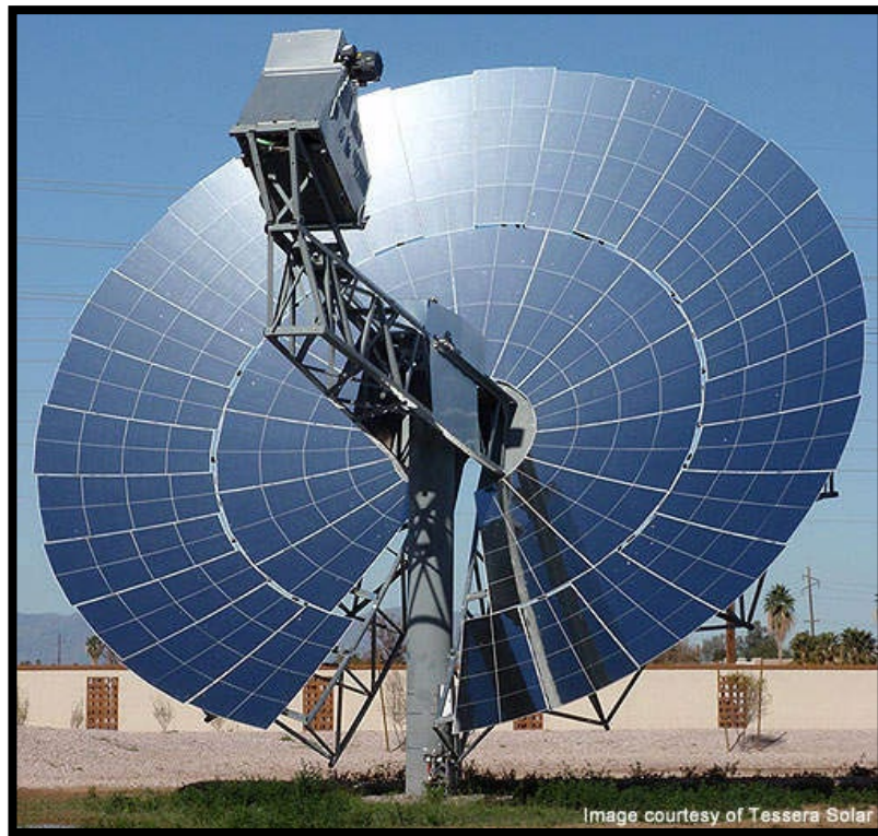
Figura 2-6. Recolector solar del proyecto Maricopa Solar [21]
