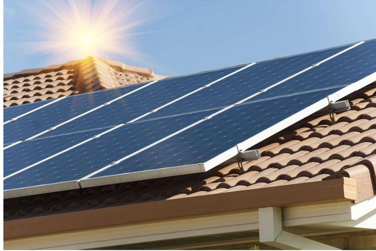
Figura 24. Módulos fotovoltaicos dispuestos de forma coplanar
