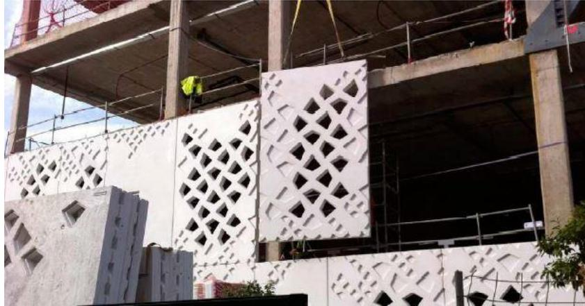
*Figura 61. Paneles prefabricados de hormigón PREHORQUISA [19]*
