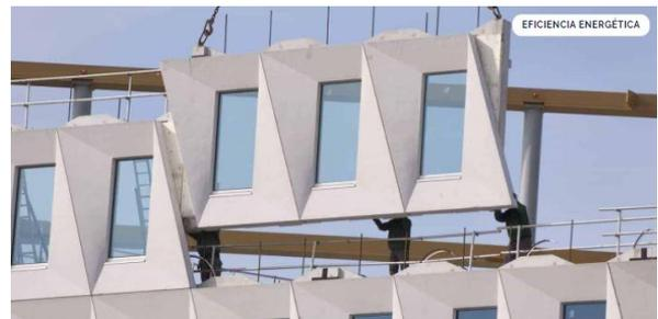
Figura 7. Elementos prefabricados [5]
