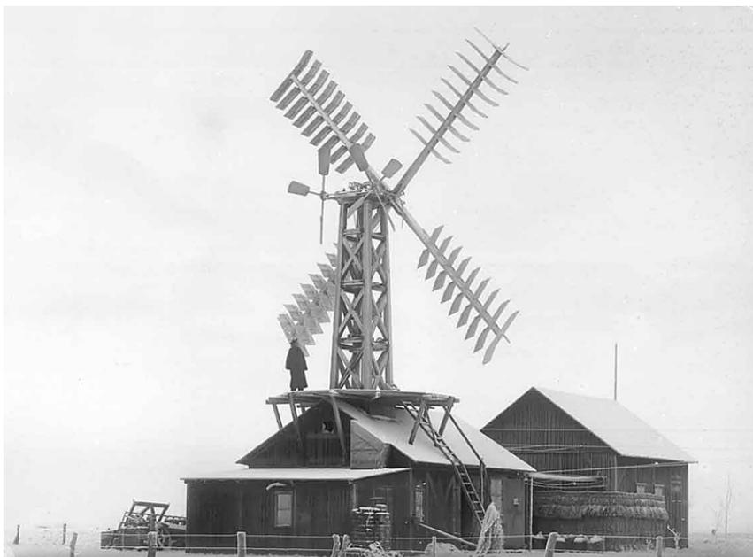
Ilustración 20. Turbina eólica de Poul La Cour Askov
