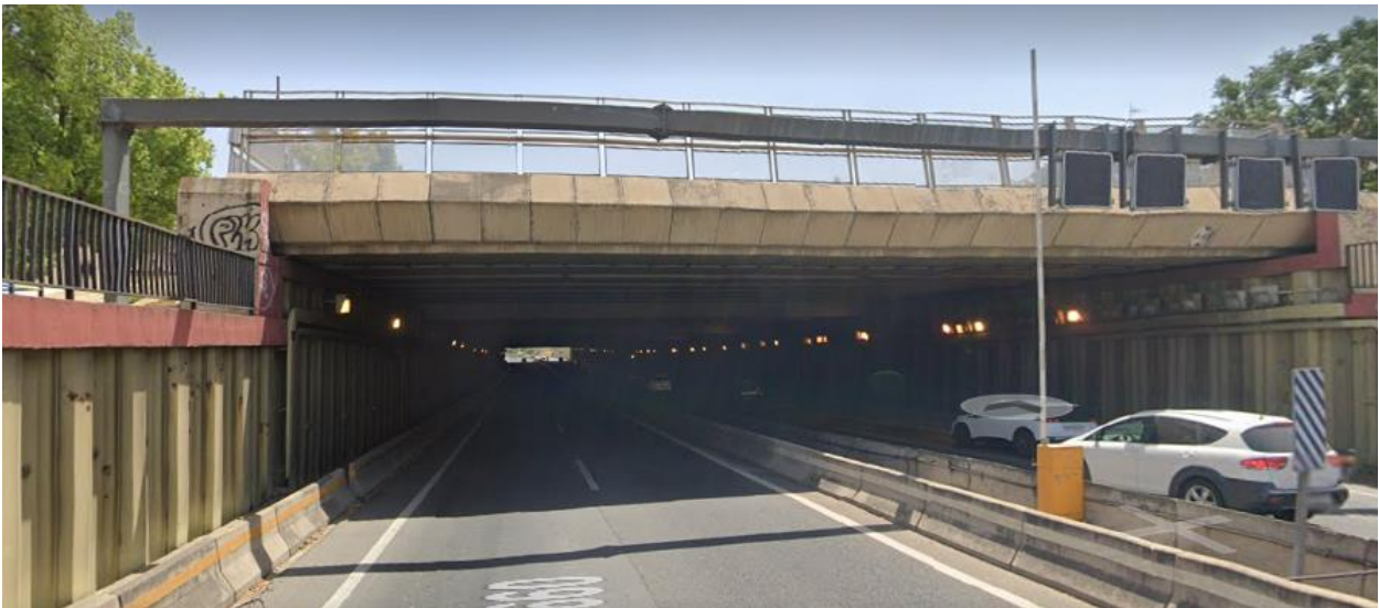
Figura 6: Túnel de Cardenal Bueno Monreal a su paso por La Palmera.
