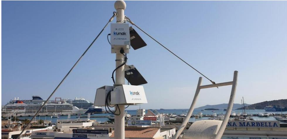
Imagen 48. Sensores de partículas y acústico. [19]
