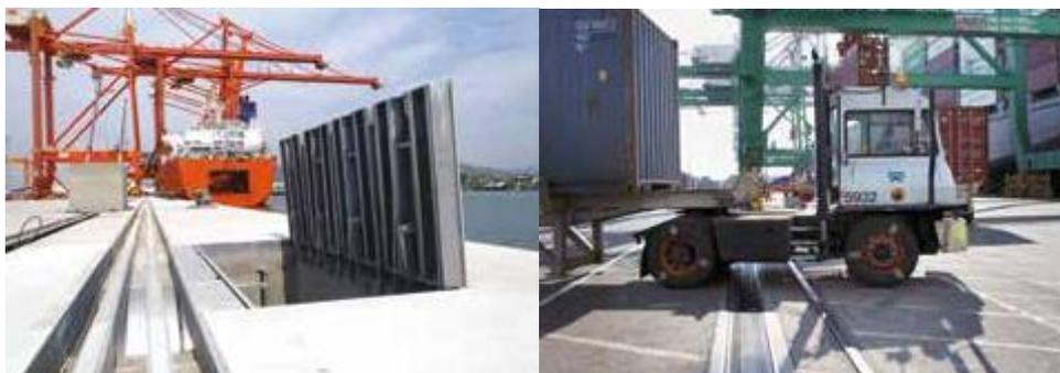
**Imagen 44. Sistema de protección de cables. [15]**
