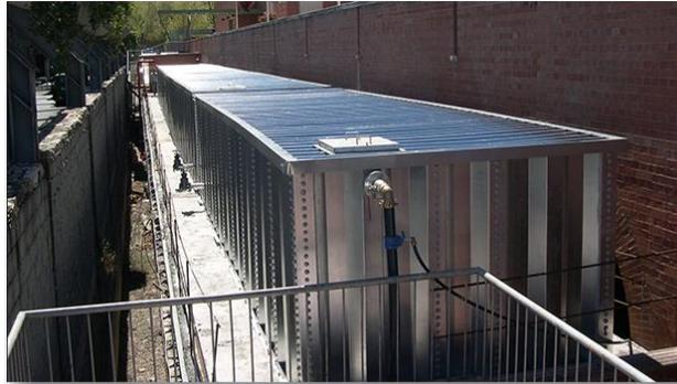
Figura 3.4.- Tanques rectangulares (42)
