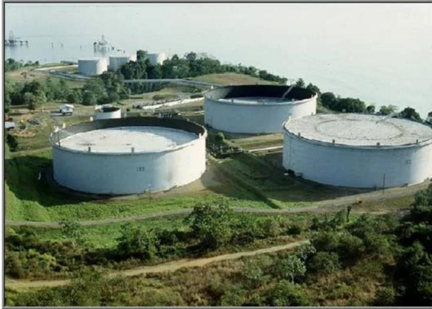
Figura 4.1.- Tanque de techo flotante techo contraído (48)
