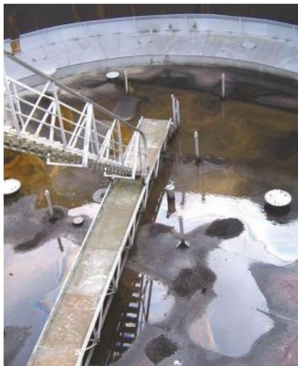
Figura 4.12.- Agua acumulada sobre el techo flotante (56)
