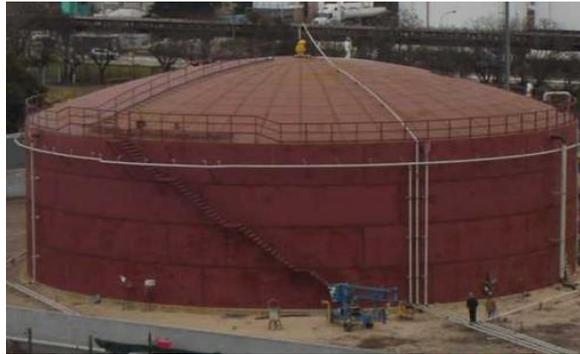
Figura 3.5.- Tanque de techo cónico o fijo (45)
