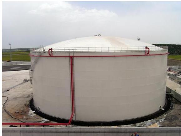
Figura 3.6.- Tanque de techo flotante (43)
