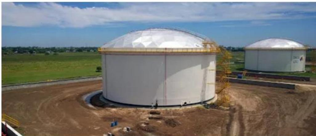
Figura 4.2.- Tanque de techo flotante techo expandido (48)
