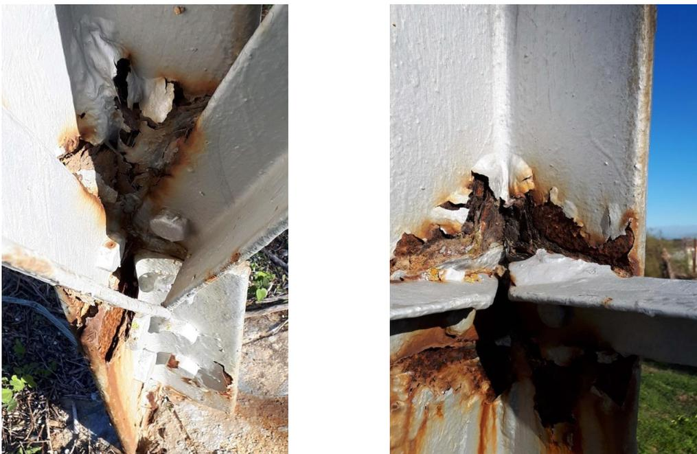
Figura 1-1. Corrosión – Deterioro del apoyo 415 de la línea Puerto Real – Majadillas
