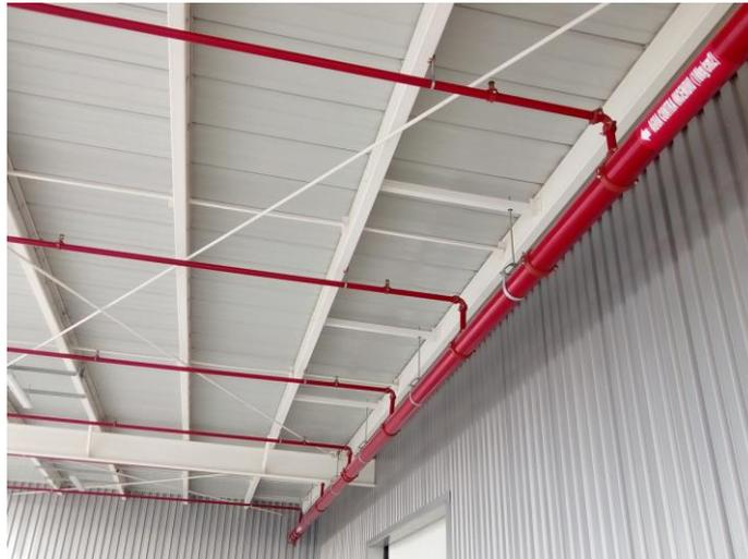
*Ilustración 54. Tuberías de distribución de rociadores automáticos*
