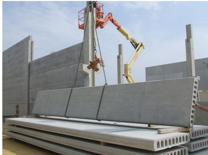
*Ilustración 28. Placas de hormigón prefabricadas*
