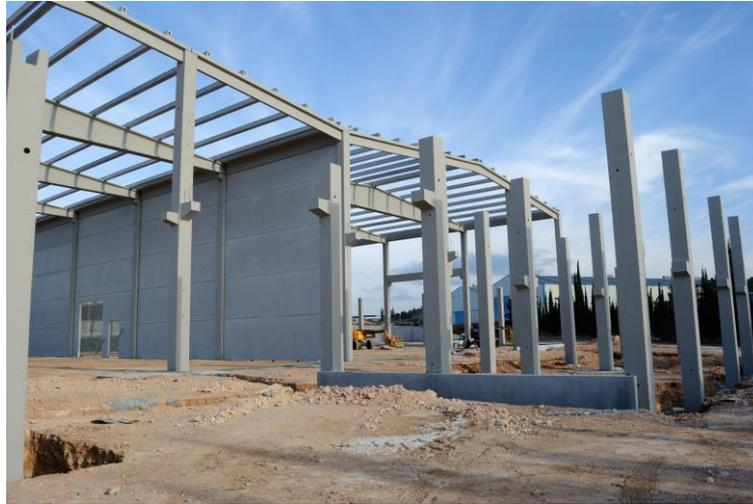
*Ilustración 21. Estructura de la nave industrial de hormigón prefabricado*
