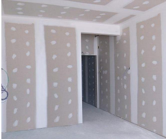
*Ilustración 30. Revestimiento del interior de la zona de oficinas*
