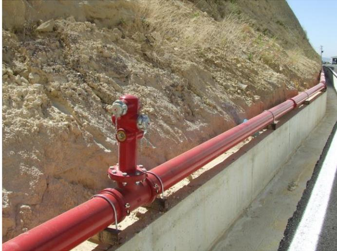
*Ilustración 46. Sistema de hidrantes exteriores*
