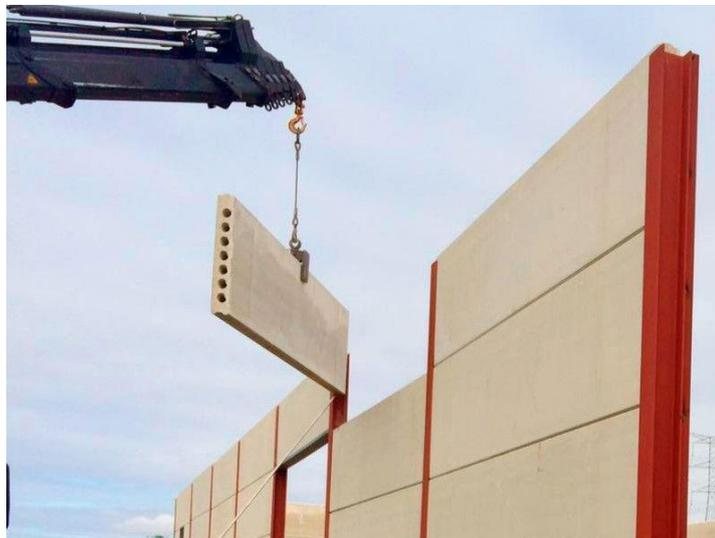
*Ilustración 23. Proceso de montaje de cerramiento de hormigón prefabricado*
