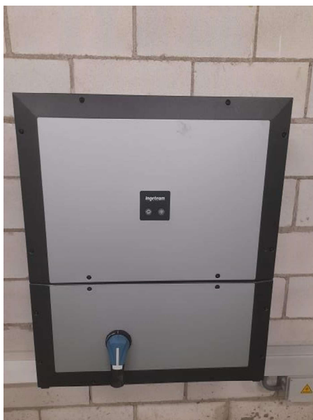
Ilustración 53 Inversor Ingeteam
