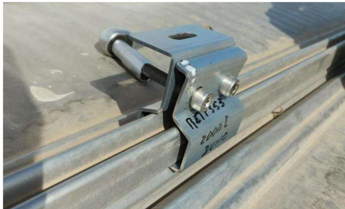
Ilustración 8 Anclaje para panel coplanar
