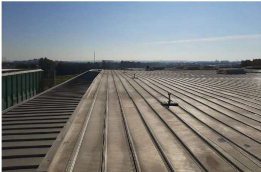
Ilustración 16 Cubierta Fibes II - 1
