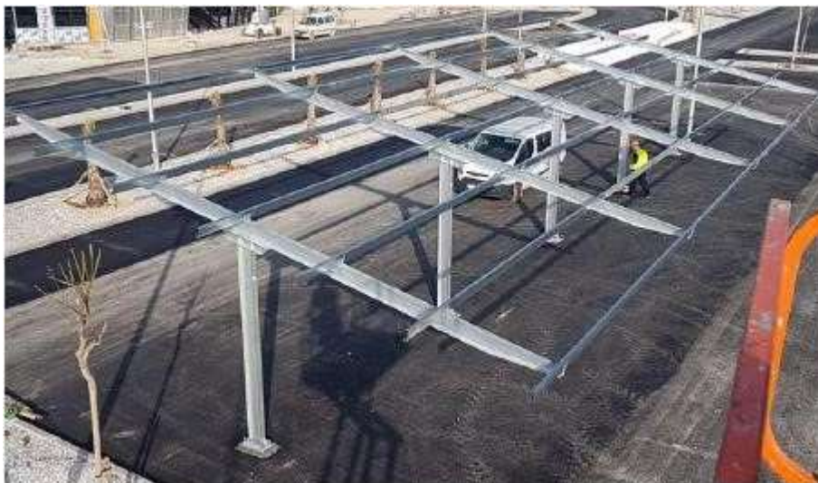
Ilustración 44 Montaje estructura marquesinas
