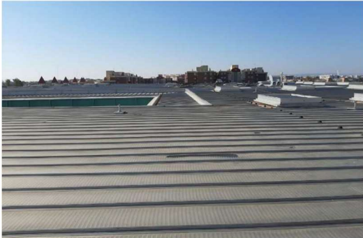
Ilustración 17 Cubierta Fibes II - 2
