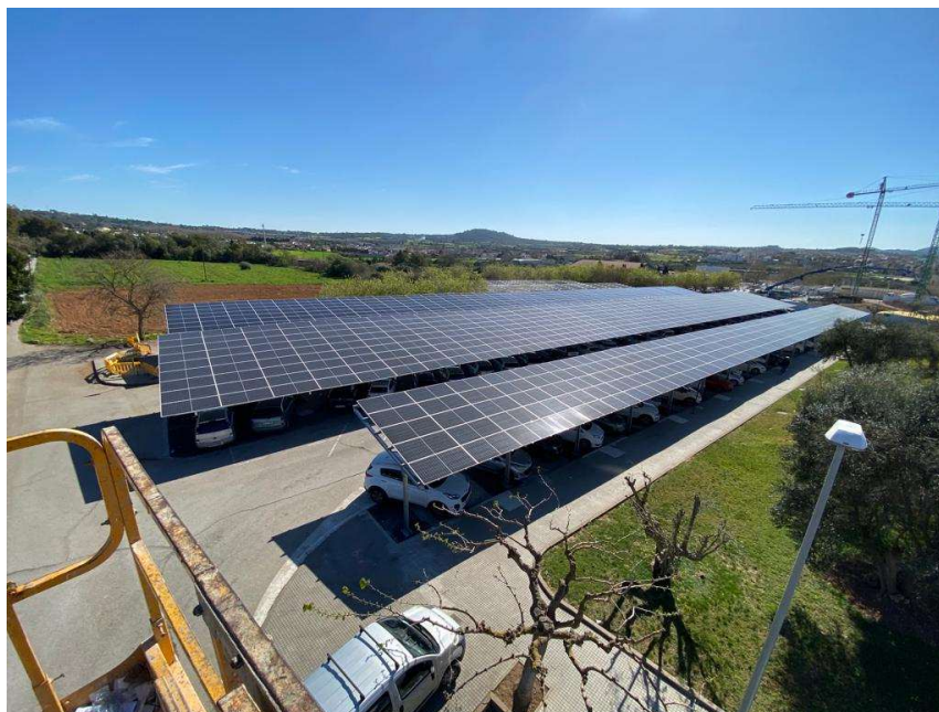
Ilustración 47 Vista obra finalizada
