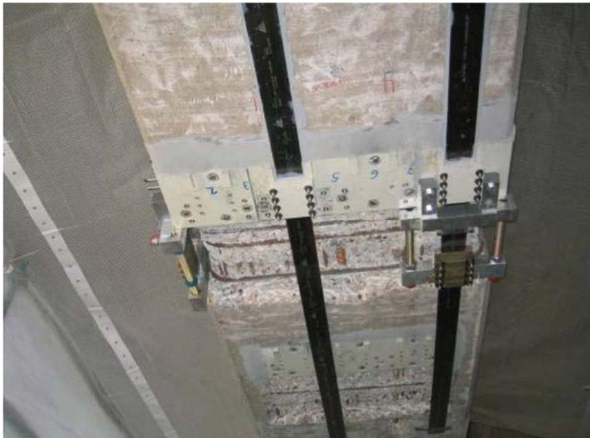
*Fig. I.4.9. Rehabilitación de juntas de dilatación utilizando tiras pretensadas de CFRP y anclajes con placas de acero, en un puente de carretera en Heilbronn (Fuente: [5]).*
