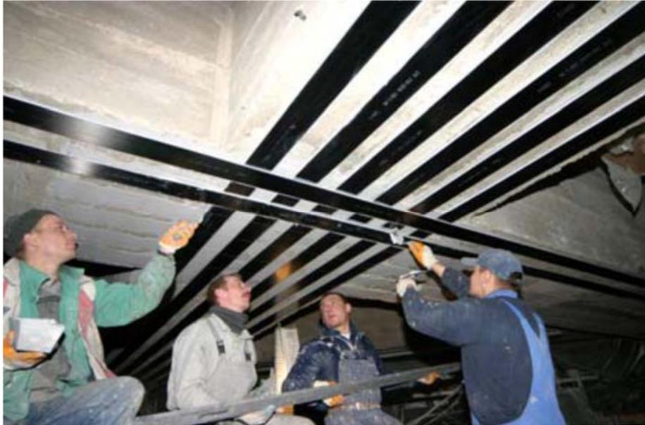
Fig. I.4.4. *Refuerzo a flexión de vigas de hormigón con tiras de CFRP, en Polonia*
