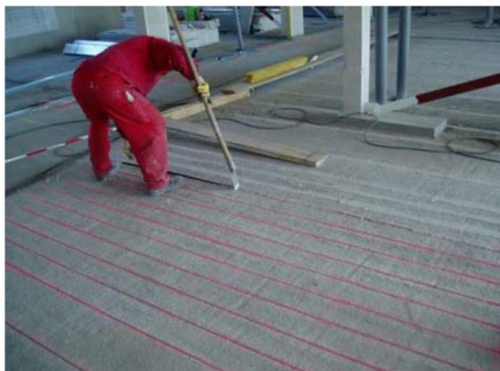
Fig. I.4.6. Refuerzo a flexión de una losa de hormigón en la zona de momento negativo usando la técnica NSMR, en una planta industrial en Stuttgart (Fuente: [5]).
