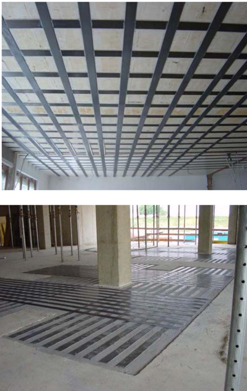
Fig. I.4.3. *Refuerzo a flexión con tiras de CFRP de una losa de hormigón. Primera foto: cara inferior. Segunda foto: cara superior (Fuente: [5]).*
