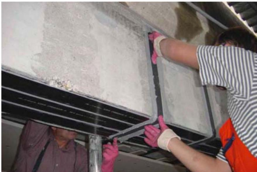
Fig. I.4.5. *Refuerzo a cizalladura (y a flexión) de viga de hormigón con tiras de CFRP, en el puente Duttweiler en Zurich* (Fuente: [5]).
