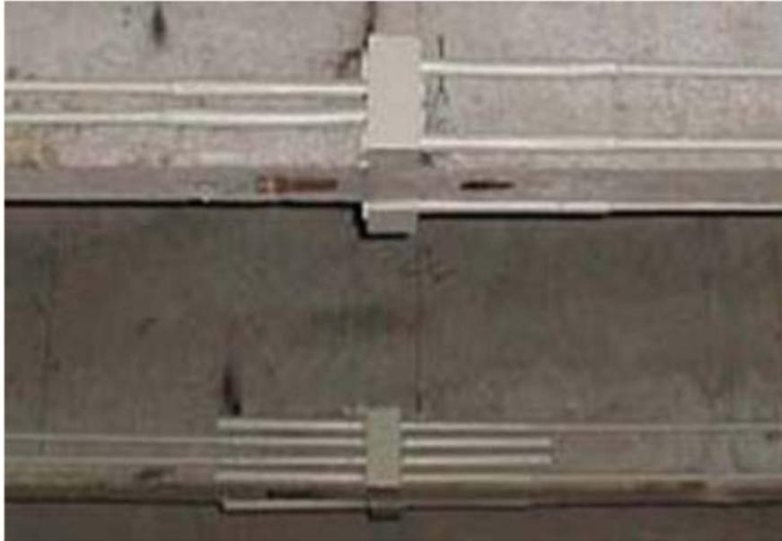
Fig. I.4.2. *Pretensado exterior de vigas (Fuente: [4]).*
