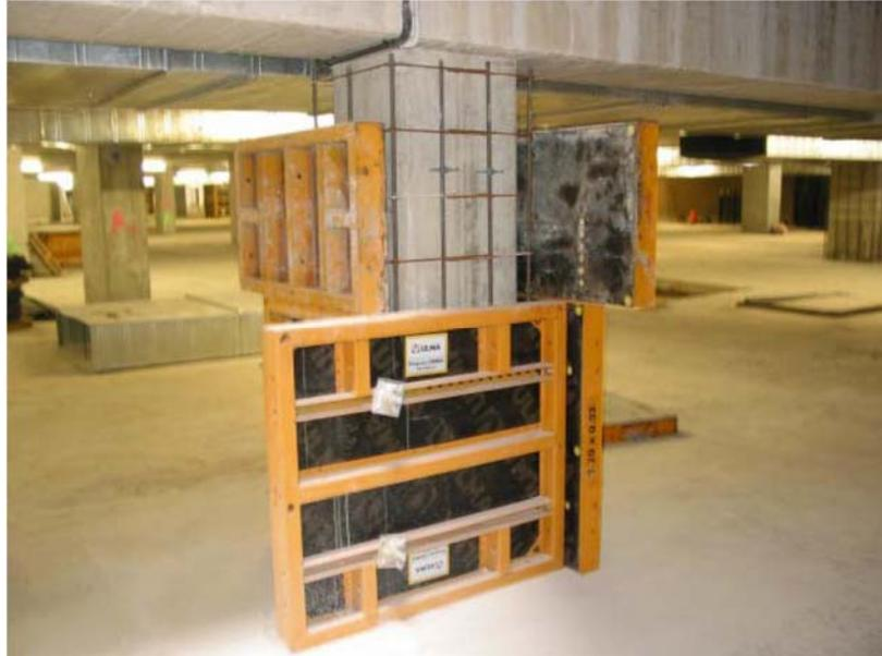
Fig. I.4.1. *Aspecto típico de un pilar durante el proceso de ejecución de un refuerzo con encamisado de hormigón armado (Fuente: [4]).*
