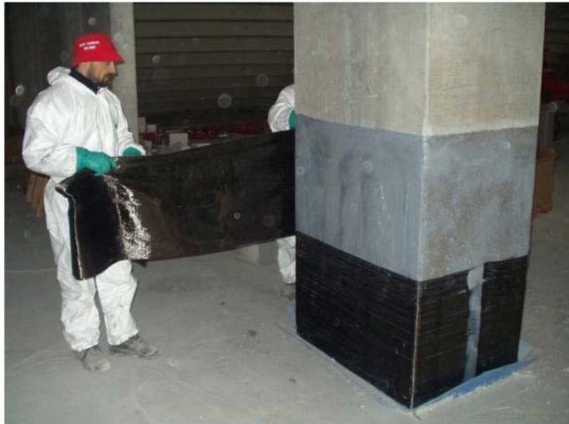
Fig. I.4.7. Refuerzo sísmico de columnas de hormigón con láminas de CFRP, en el estadio Reggio Emilia en Italia (Fuente: [5]).
