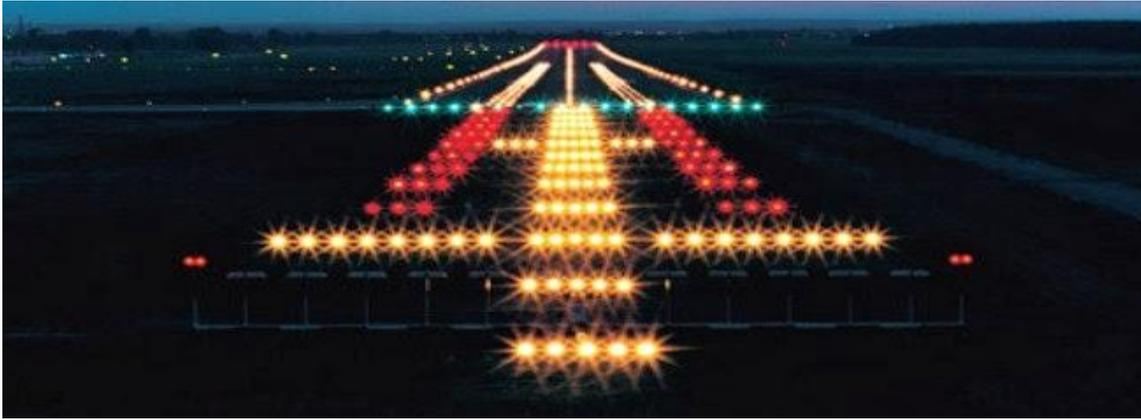
Figura 3.23. Sistema de luces de aproximación
