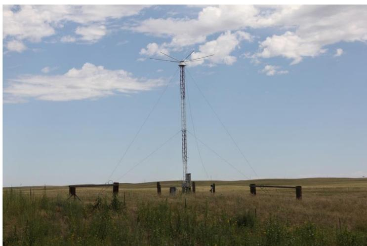
*Figura 3.6. Antena transmisora NDB*
