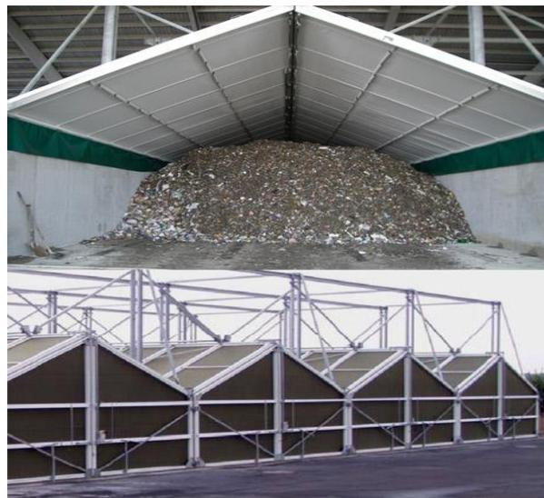
*Ilustración 14. Compostaje en túnel (11)*
