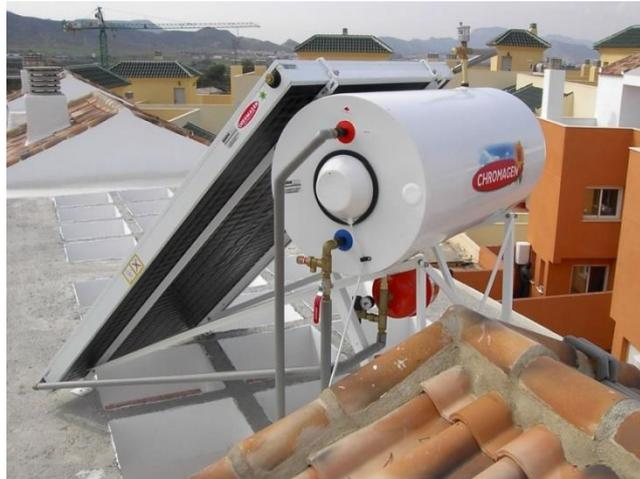
Figura 16. Depósito de acumulación.
