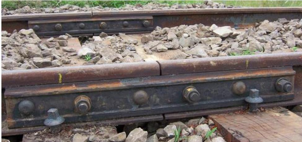
Figura 2–13. Ejemplo de junta de dilatación en las vías del tren
