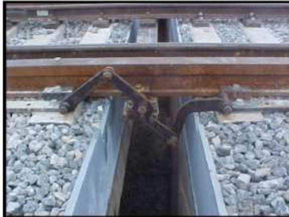
*Figura 1 Aparato de dilatación de vía en un puente de ferrocarril*
