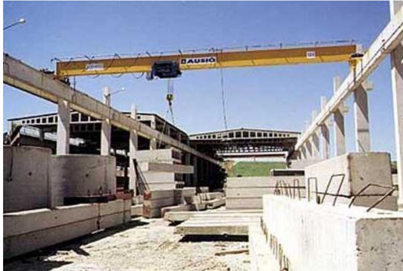
Figura 18: Puente grúa. Fuente: www.hellopro.es
