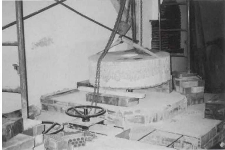
Figura 60 Colocación de la solera. Foto tomada de (8).
