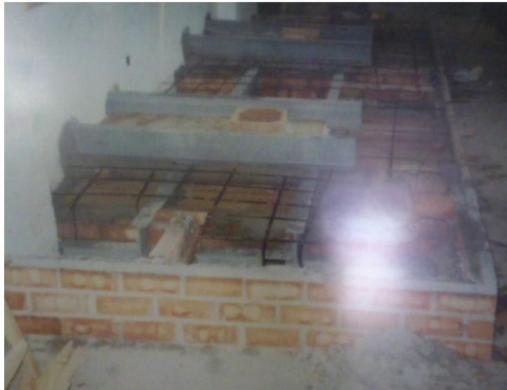
Figura 94 Reforzamiento del alfanje.
