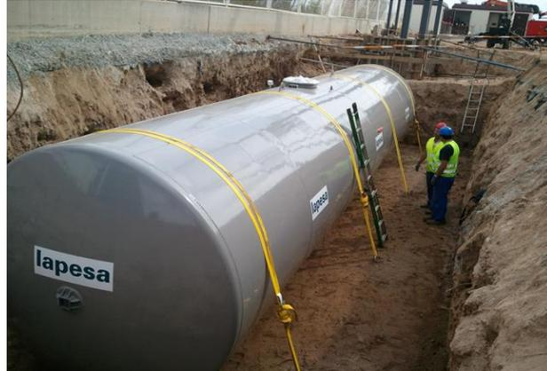
Figura 5. Tanque de combustible
