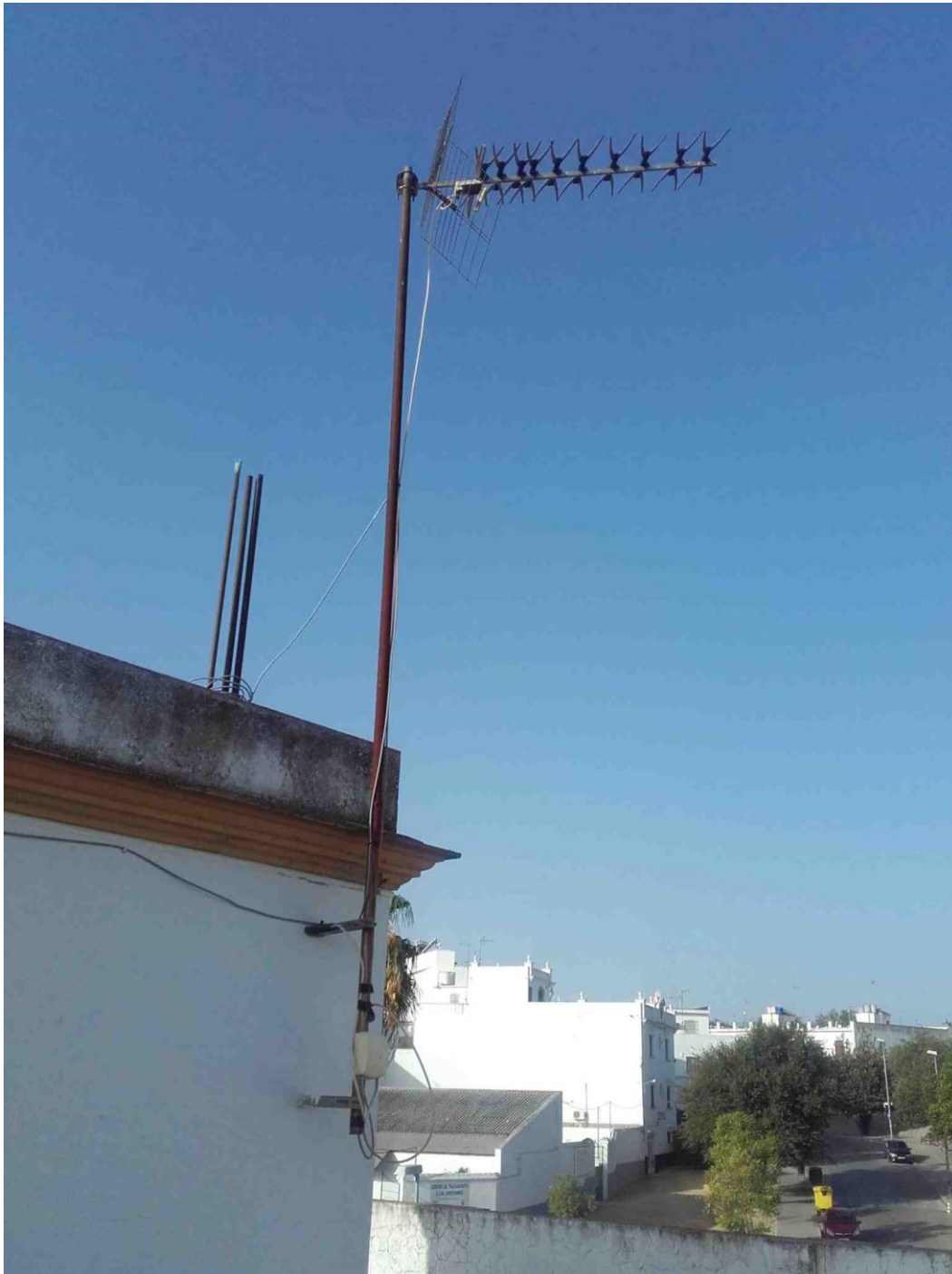
Figura 5-6 Antena tipo yagi y amplificador de mástil
